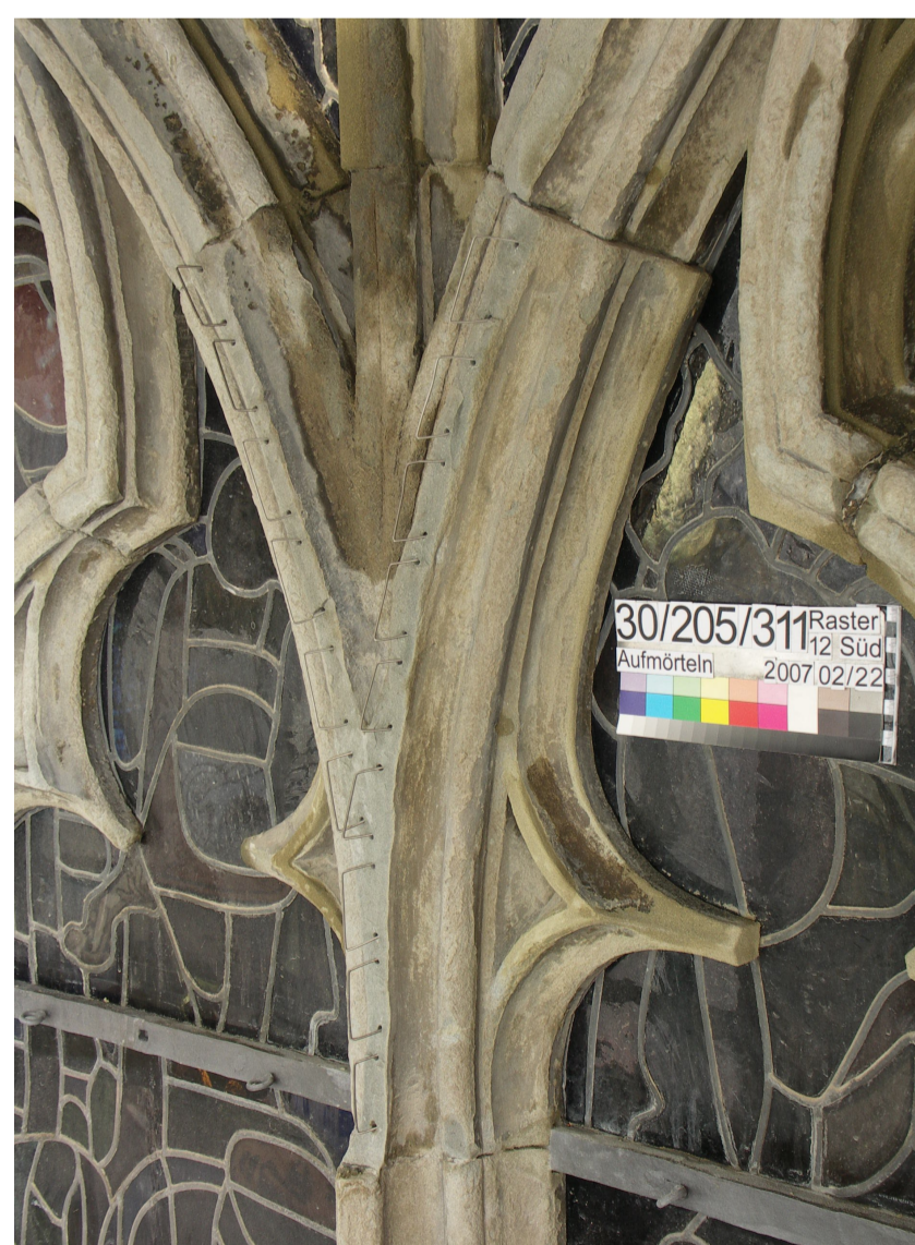
Armierungsbügel aus 2-3 mm säurebeständigen Chromstahl - Gewindestangen gewährleisten eine sichere Verbindung zum Untergrund.
