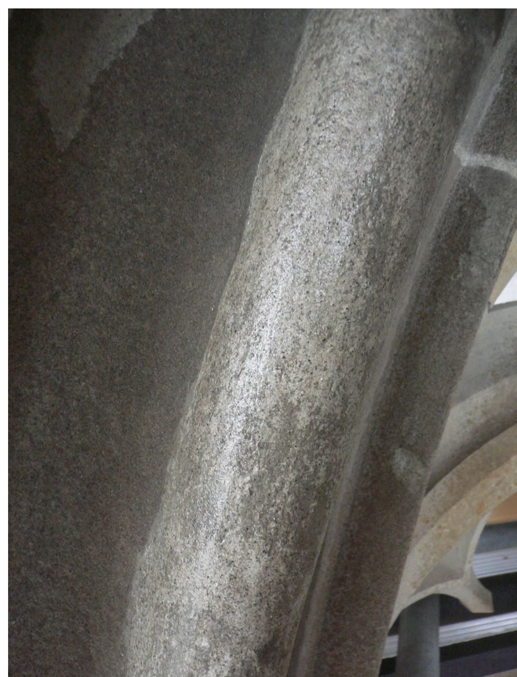
Sinterschichten (Bild oben) können durch konsequente Nachpflege des Mörtels weitgehend vermieden werden (Abtupfen, Feuchthalten, Bild unten)
