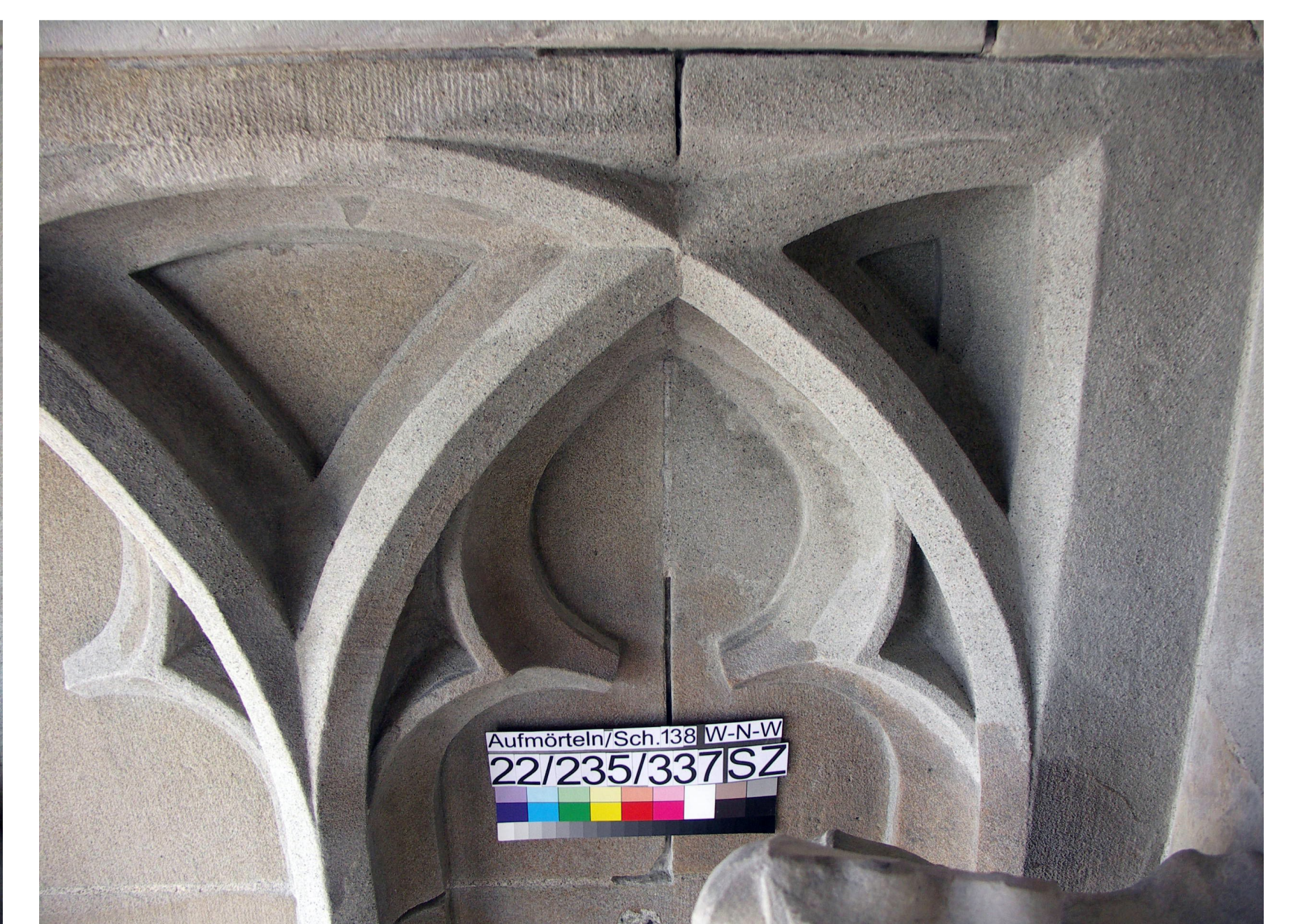
Fertig aufgemörtelt mit Deckmörtel „Zuger Mischung“. Die Kanten sind scharfkantig aufgemörtelt und unterstreichen den neugotischen Charakter.
