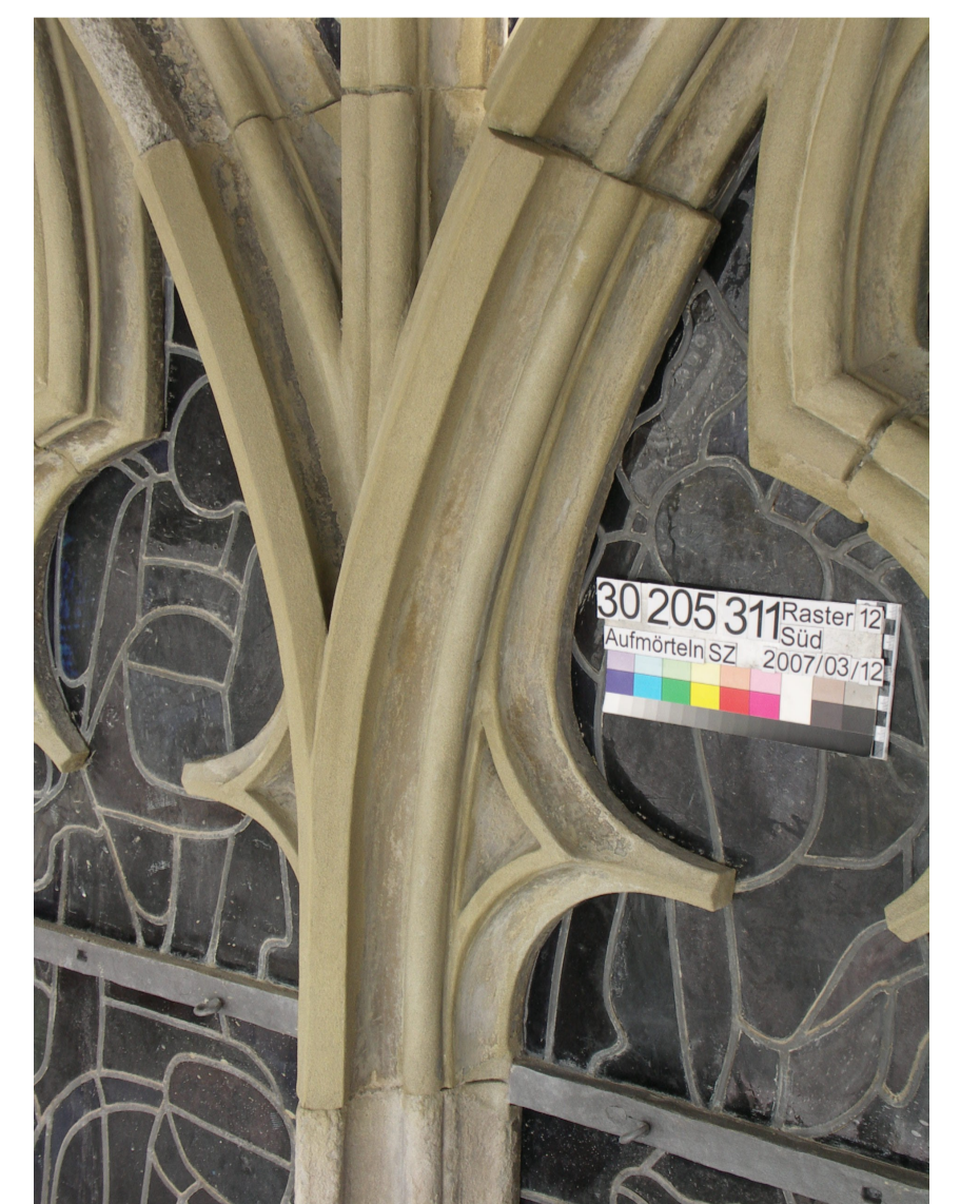
Fertig aufgemörteltes Masswerk.
