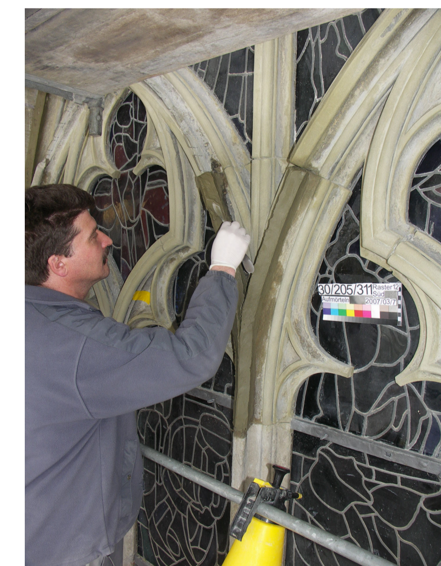
Abschliessend wird eine 5 - 8 mm dicke Deckmörtelschicht aufgetragen. Aufgrund der verschiedenen zugesetzten Sande wird damit eine sandsteinähnliche Oberfläche erreicht. Sehr viel Fingerspitzengefühl benötigt das abschliessende Abtupfen mit einem Mikroporenschwamm, hier entscheidet sich die endgültige Optik und Oberflächenqualität.
