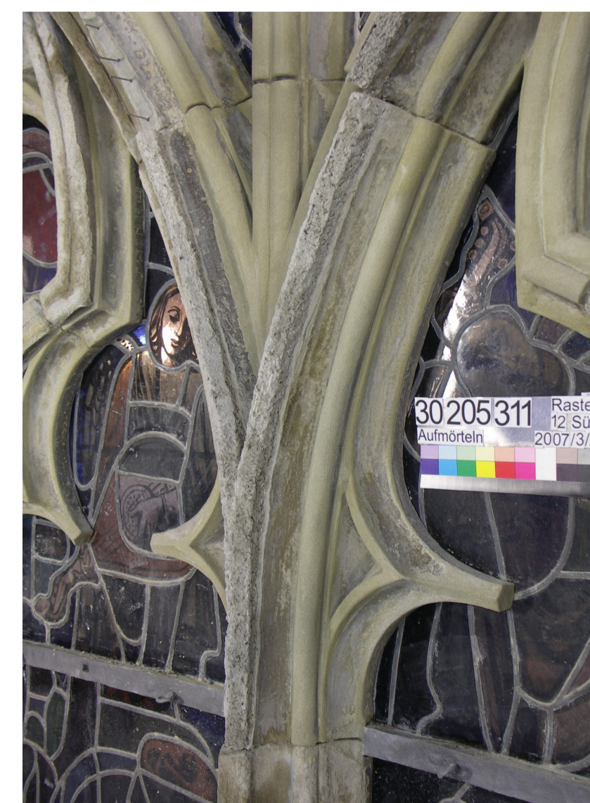
Mit dem gröberen Kernmörtel werden tiefe Fehlstellen aufgebaut. Durch die spezielle Korn- und Bindemittelzusammensetzung wird die Bildung von Schwundrissen verhindert.
