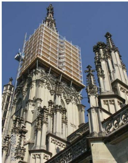
Heute sind wir auf einem Projektierungsstand, wo das Gerüst für das Turmoktagon in der virtuellen Realität existiert, bevor es passgenau am Turm selbst errichtet wird.
