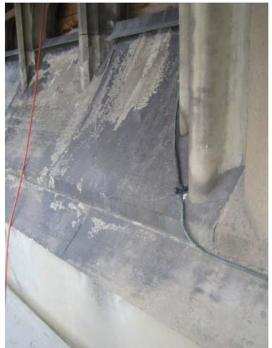
lagerungen. Am Münster werden entsprechende Stellen ebenfalls als Krusten bezeichnet. Krusten an regengeschützten Stellen entstehen aus trockener Deposition von Luftschadstoffen – meist Gipskrusten mit dunklen Staubpartikeln. Die Bildung dieser Art von Krusten wird sich aufgrund der verbesserten Luftqualität in Zukunft tendenziell verlangsamen.
