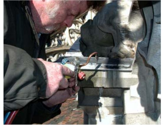
und hygrischen Dehnung (z. B. an der Westfassade bei einem Platzregen im Mai) oft Bewegungsrisse in den verbundenen Werkstücken. Durch eine möglichst duktile Lagerfugenarmierung über möglichst viele Werkstücke hinweg sollte diesem Problem entgegen gewirkt werden. Dabei wurde in Anlehnung an moderne Mauerwerksarmierungen ein einfaches, kostengünstiges System mit Lochblechen entwickelt. Die Löcher wurden mit einem Gemisch aus Sumpfkalk, hydraulischem Kalk und wenig Weisszement gefüllt.
