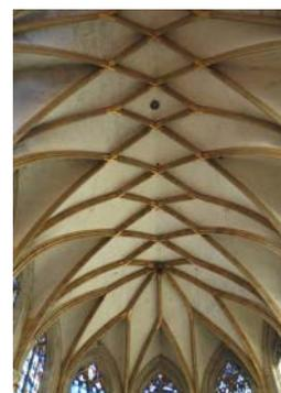
oben: Luc Mojons Rekonstruktion des möglicherweise in Bern geplanten Rauten- bzw. Parallelrippengewölbes.
