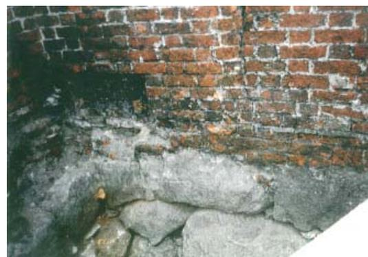
Der Injektionsmörtel dagegen würde seitlich wegfließen, in Grablegen und zu anderen Bodendenkmalen – es gibt ein Radarbild, das zeigt, was davon im Erdreich gefunden wurde. Und auch dieses: Der Mörtel würde die kapillarbrechende Wirkung der Hohlräume aufheben, es käme zu verstärktem Feuchteanstieg.
