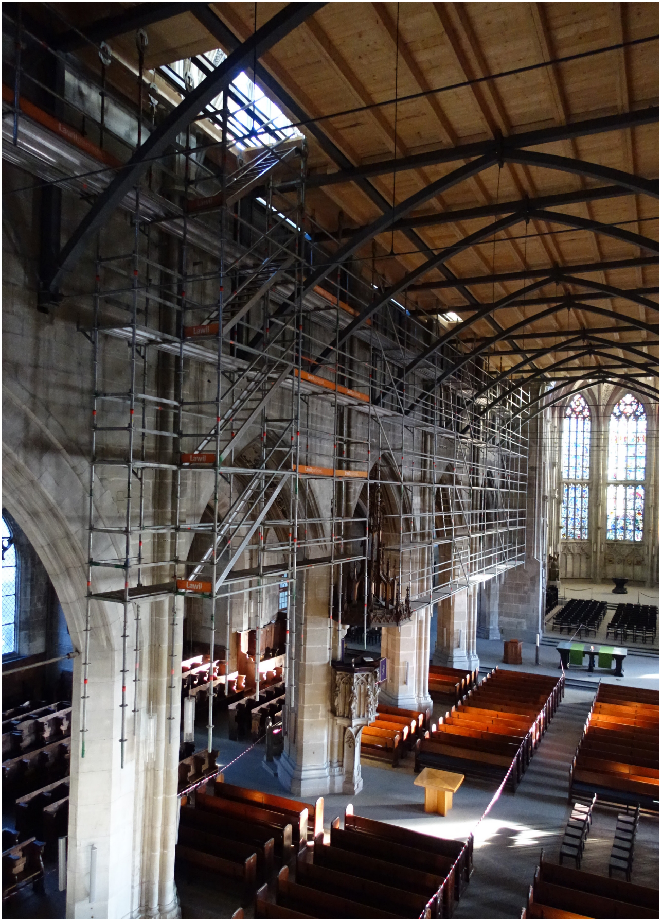
Bau des Hängegerüstes an der nördlichen Hochschiffwand. Damit der Kirchenbetrieb auch während der Reinigung der Innenwände weiterlaufen konnte, wurden in zwei Etappen (2023 Nordseite, 2024 Südseite) Wandflächengerüste an vorgängig auf der Gerüstplattform im Gewölbe eingebrachten Stahlträgern abgehängt. Die Reinigung der Pfeiler erfolgte mit kleinen Gerüsten und Leitern von unten.
