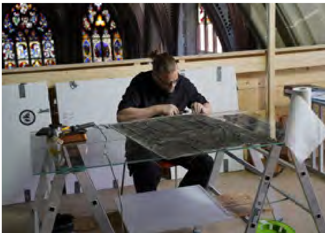
Glasmaler Daniel Stettler bei der Arbeit im temporären "Glasatelier" auf der Gerüstplattform unter dem Mittelschiffgewölbe: Kittreste im Randbereich wurden mittels Skalpell und Reibholz abgetragen und wo nötig entfernt. Um das Risiko eines Transportes zu minimieren, wurden alle Wappenscheiben direkt vor Ort untersucht und wo nötig restauriert. Auch das Einglasen in die neuen Schutzrahmen erfolgte direkt vor Ort.
