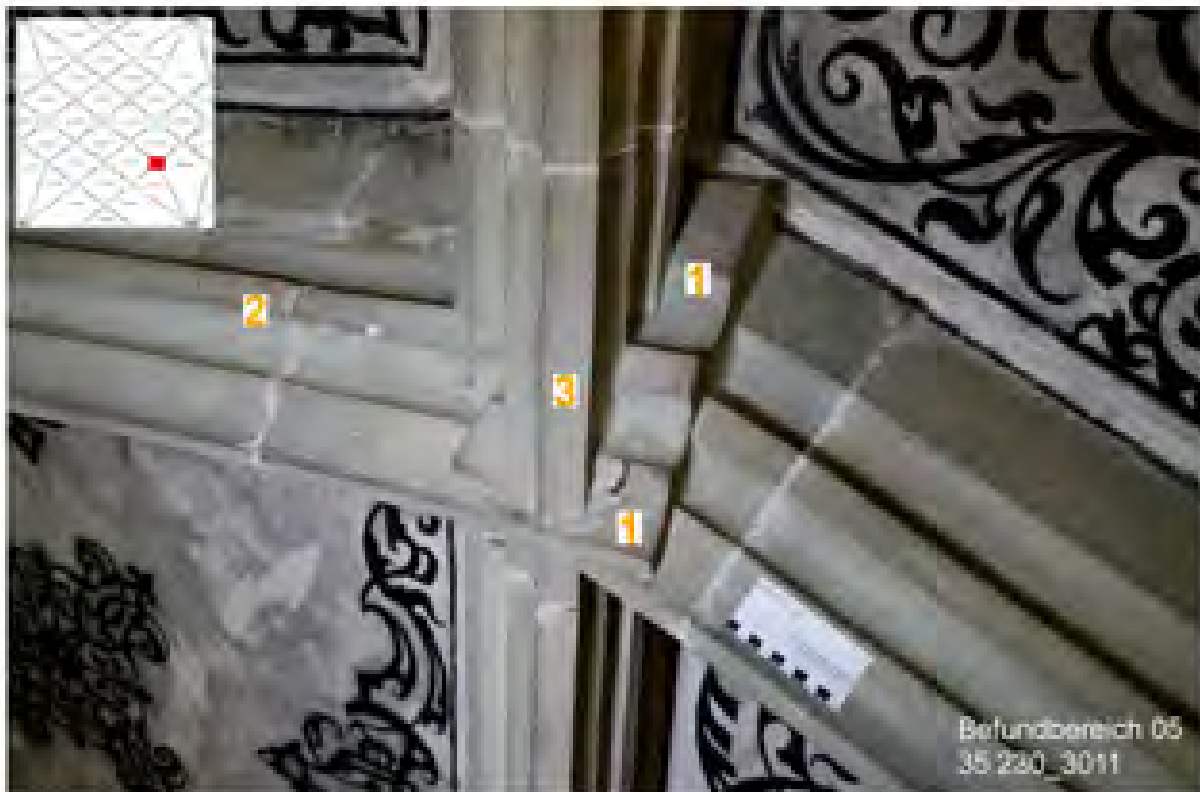
Befundbereich 05, Detail der Verunreinigungen
