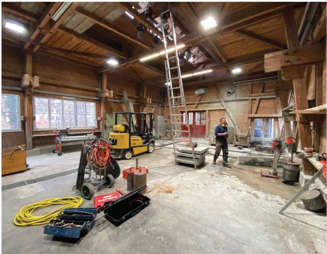
Münsterbauhütte: Sägehalle, nach dem Ausbau der alten Gattersäge. Damit wurde Raum frei für an heutige Herausforderungen angepasste Arbeitsplätze.
