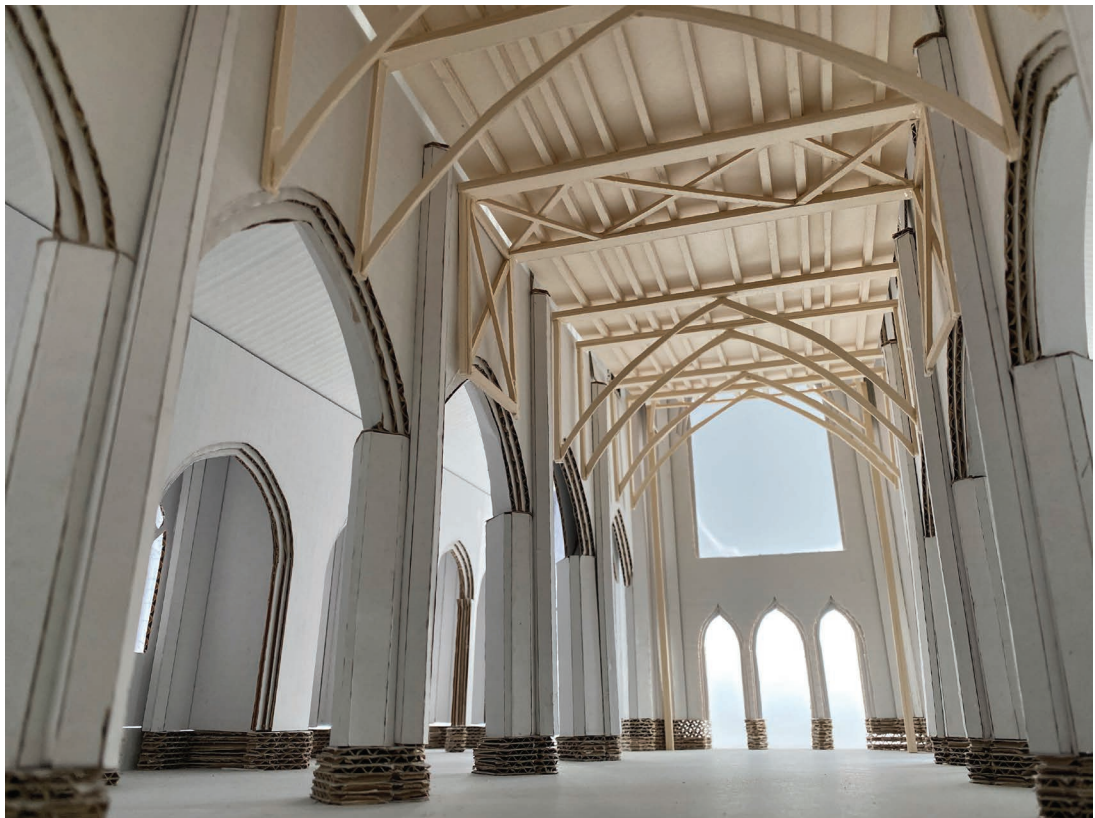
Modellfoto des nachgebauten Mittelschiffs und der Stahlkonstruktion inkl. Arbeitsplattform.
