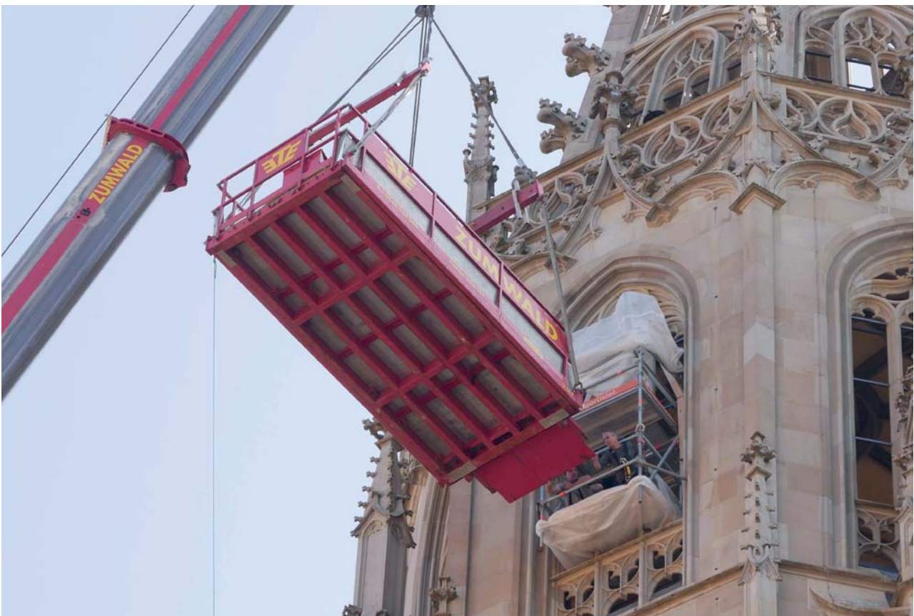
Das Andocken der Barelle auf Niveau Haspelboden und das anschließende möglichst zügige Hineinschieben der Lasten in den Turm verlangte von allen Beteiligten höchste Konzentration.
