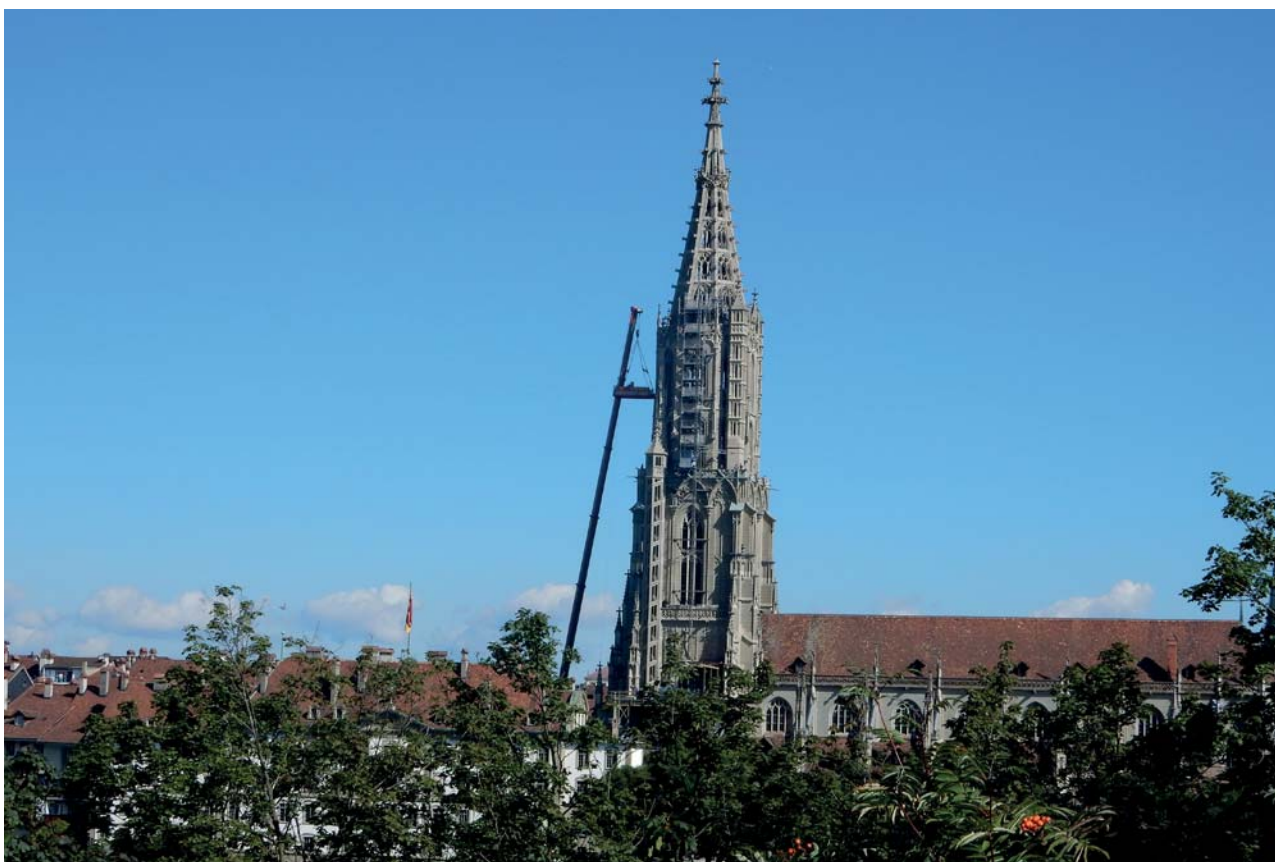
o.l. und u. Transport des Auslegearms mittels Barelle. o.r. Ausbau des Stabwerks zur Vergrößerung der Transportöffnung.
