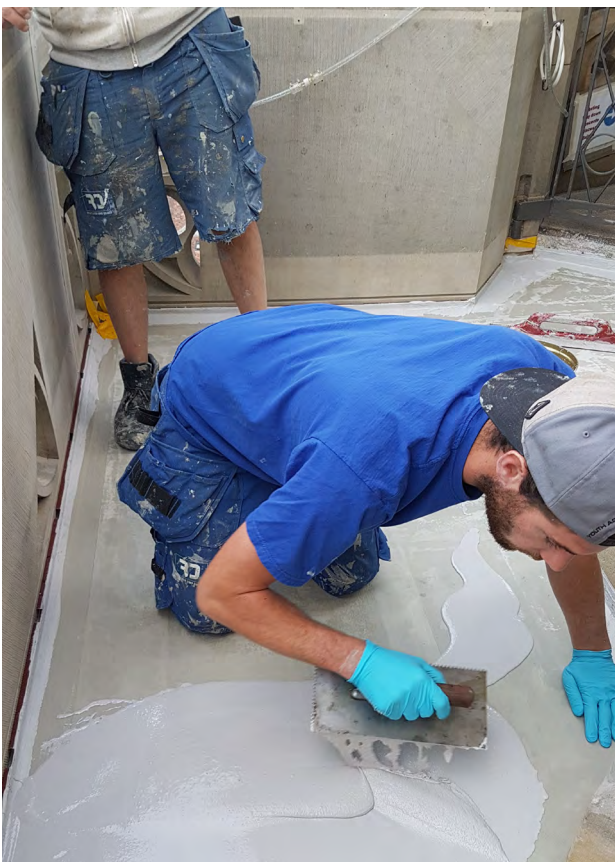
Impressionen der Arbeiten in der Viereckgalerie (untere Besucherplattform). Die Lauffläche wurde über einer Trennschicht mit Flüssigkunststoff ausgegossen.
