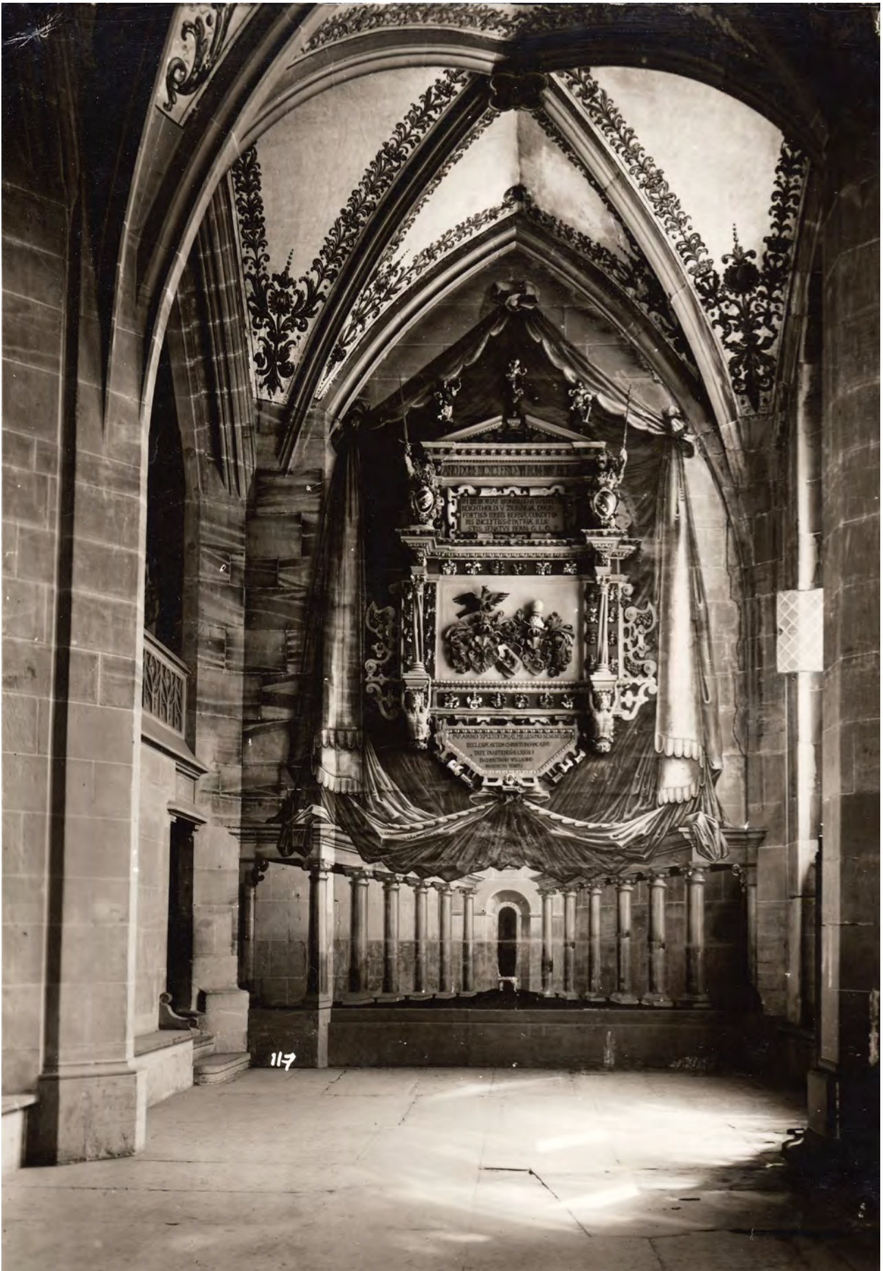
Blick in die Matterkapelle. Das Foto zeigt den Zustand vor dem Ausbruch der Türe in die Sakristei um 1918. Foto: Archiv Kantonale Denkmalpflege Bern.
