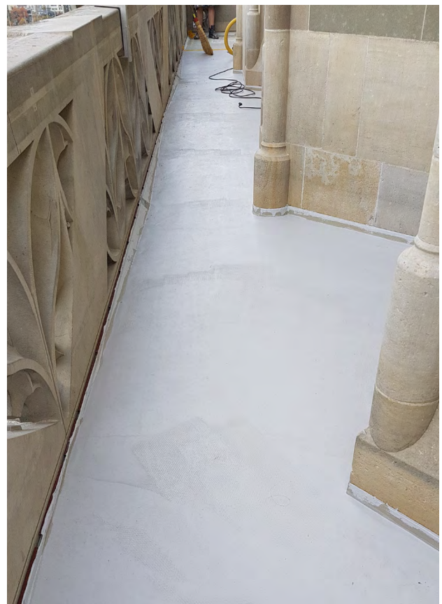
Impressionen der Arbeiten in der Viereckgalerie (untere Besucherplattform). Die Lauffläche wurde über einer Trennschicht mit Flüssigkunststoff ausgegossen.
