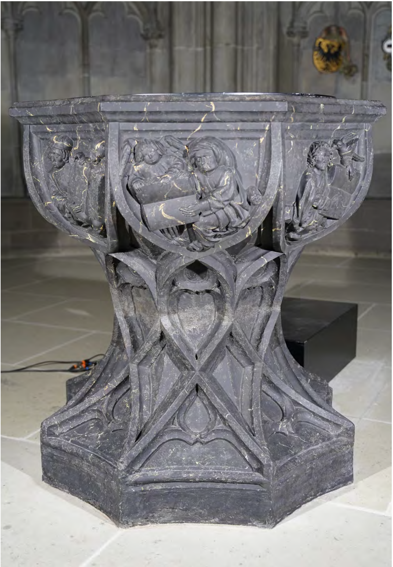
Schlusszustand Taufstein, nach der Freilegung und Retuschierung der Marmorierung. Foto: Cornelia Marinowitz, Tengen (D).
