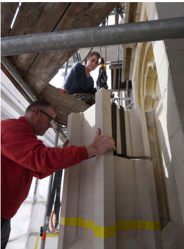
Impressionen vom Versetzen eines neuen Fialenschafte an der Vorsatzfiale am Pfeiler 95 Süd. Der Steinaustausch erfolgte aufgrund beunruhigender Rissbildungen am Schaft aus Zuger Sandstein aus der Zeit um 1913. Die Werkstücke wurden neu in Obernkirchener Sandstein angefertigt.
