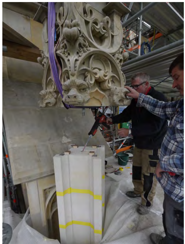
Impressionen vom Versetzen eines neuen Fialenschafte an der Vorsatzfiale am Pfeiler 95 Süd. Der Steinaustausch erfolgte aufgrund beunruhigender Rissbildungen am Schaft aus Zuger Sandstein aus der Zeit um 1913. Die Werkstücke wurden neu in Obernkirchener Sandstein angefertigt.
