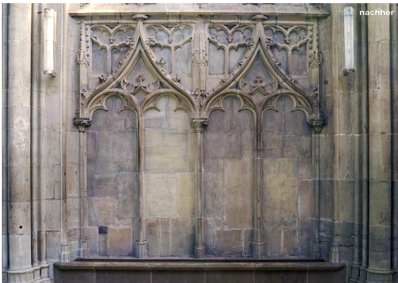
Nordwand im Altarraum: oben Vorzustand, unten Schlusszustand nach der Reinigung und Retuschierung. Foto (o.): Nick Brändli, Zürich.
