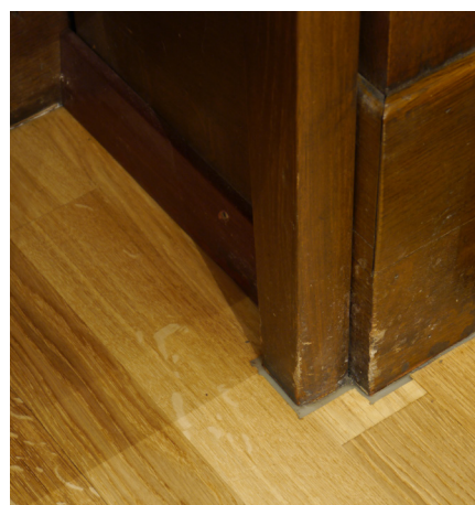
Pfarrstube in der Erlach-Ligerz Kapelle 20.210.311. Rechts Detail vor und nach dem Schleifen und Ölen des neuzeitlichen Parketts.
