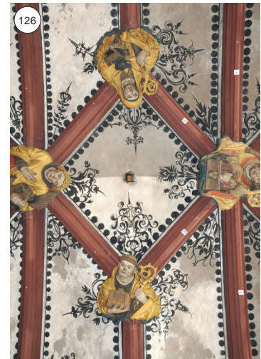
Über Jahrhunderte hat sich eine fest verbundene Staubschicht gebildet, die in einem ersten Arbeitsschritt, dem Absaugen, mit Spezialschwämmen (Wishab) abgenommen werden musste. Darunter kam die originale Oberfläche von 1517 zum Vorschein und die Retuschen von 1910, die sich jetzt dunkel markierten.
