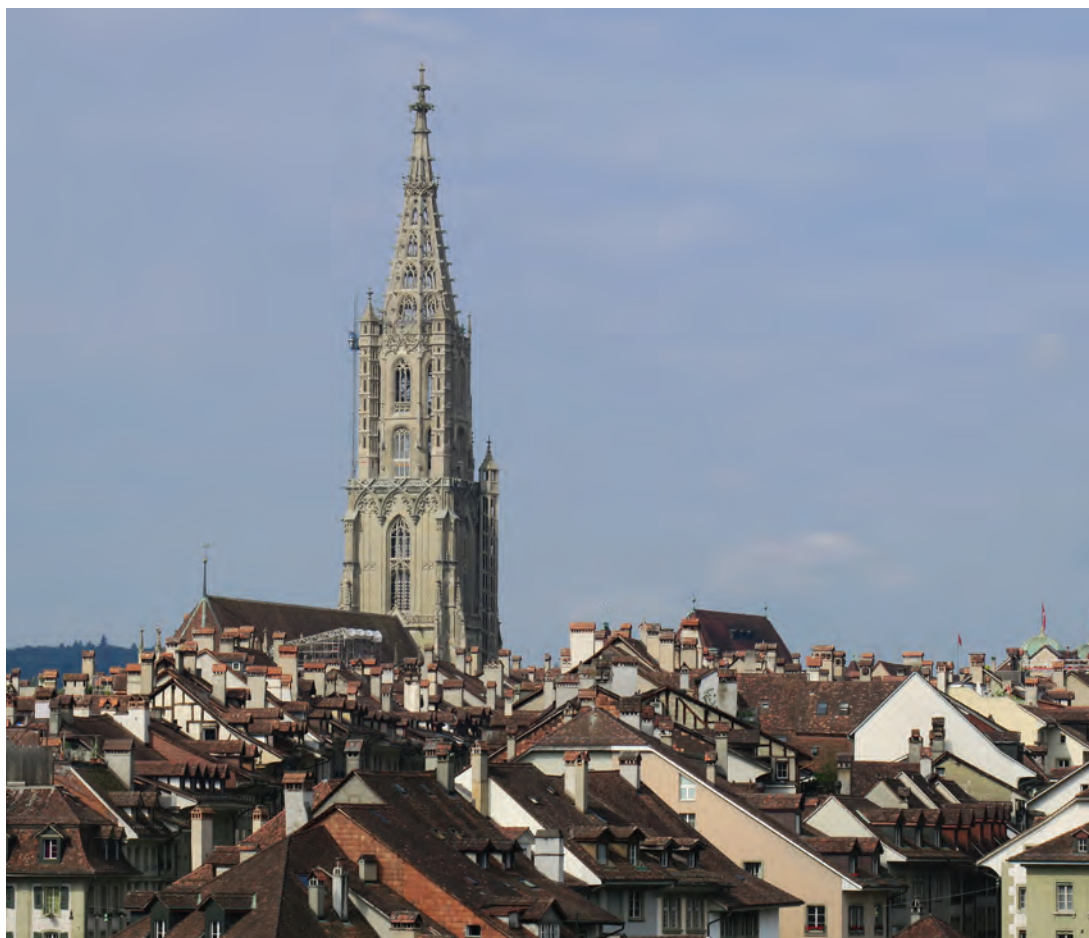
Berner Münster - Blick auf die restaurierte Ost- und Nordfassade des Münsterturms.
