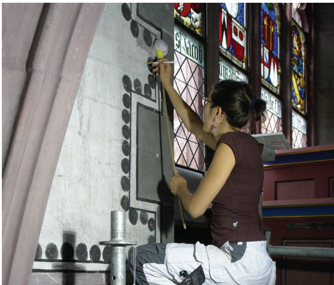
Régine Saucy (o.) und Rowena Pasche (u.) beim Retuschieren der Wandflächen in Strichretusche auf dem bereits teilweise rückgebauten Gerüst.
