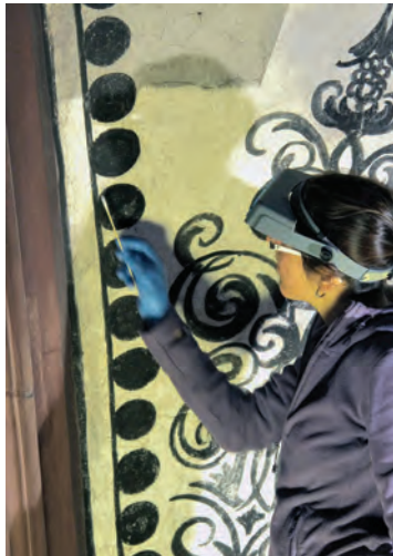
Nach der Trockenreinigung mit Wishab-Schwämmen wurden die gesamten Kappenflächen mit dem Wattestäbchen und klarem Wasser nachgereinigt. Zum Schluss sind wenige störende Fehlstellen (hier an den Wandflächen) in Tratteggio-Technik (Strichretusche) geschlossen worden.
