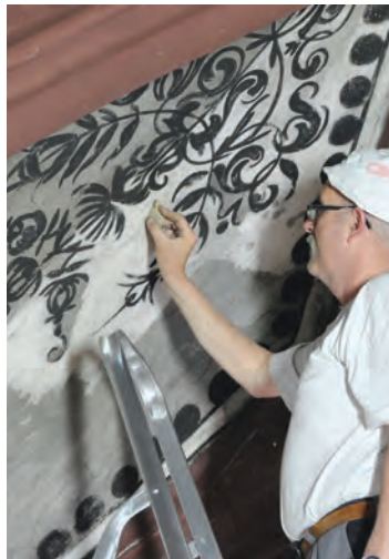
Über Jahrhunderte hat sich eine fest verbundene Staubschicht gebildet, die in einem ersten Arbeitsschritt, dem Absaugen, mit Spezialschwämmen (Wishab) abgenommen werden musste. Darunter kam die originale Oberfläche von 1517 zum Vorschein und die Retuschen von 1910, die sich jetzt dunkel markierten.
