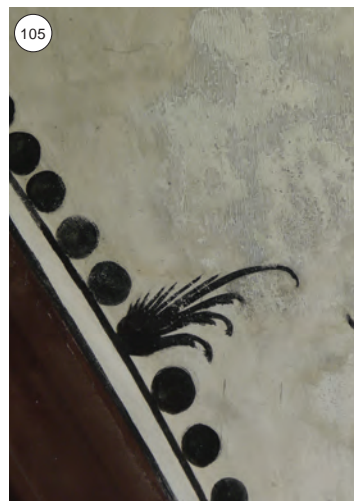
105 Schabernack im Chorgewölbe. Alle Kappen sind gesäumt von Kugelornamenten, die sich wie eine Perlenkette an den Rippen entlang zieht. An zwei Stellen sind wie auf dem Bild zwei „explodierende“ Kugeln zu finden.
