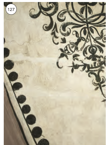
Die Kappe im Endzustand nach Abnahme der Retuschen von 1910 und der Überarbeitung der Kittungen. Sie wurden sehr oberflächlich geebnet und retuschiert.
