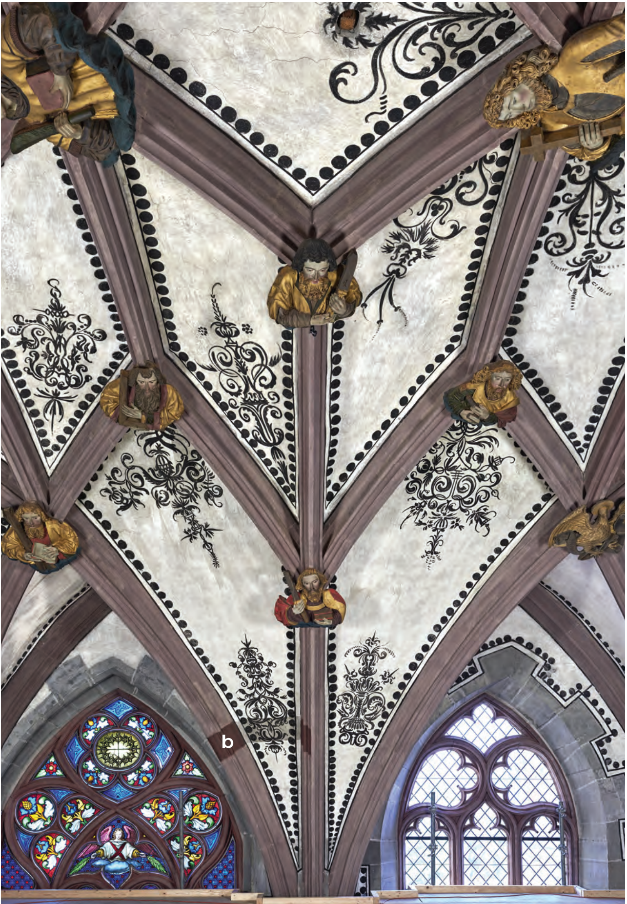
Musterachse im gereinigtem Schlusszustand. b) Eine Referenzfläche wurde im ungereinigten Zustand belassen. Schlusszustandsfoto Nick Brändli, 2017.
