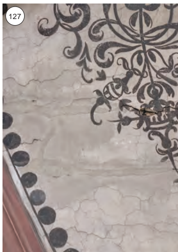
Die Kappen im Vorzustand mit Verschmutzungen und den Kittungen und Retuschen von 1910.
