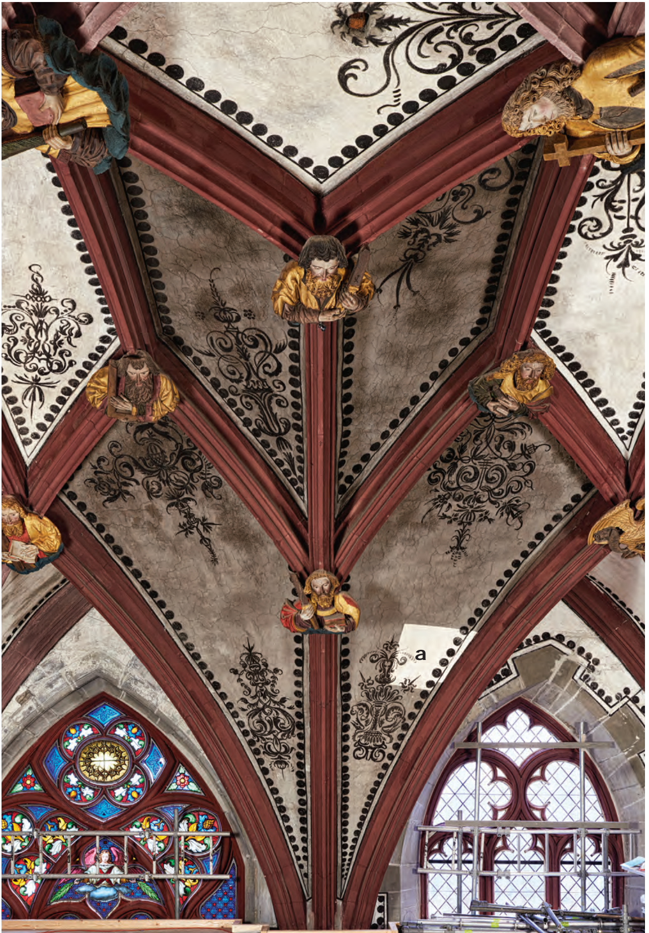
Musterachse im Chorgewölbe Süd mit noch verschmutzten Gewölbekappen. a) Die weissen Flächen sind bereits trocken gereinigt. Zwischenzustandsfoto Nick Brändli, 2015.
