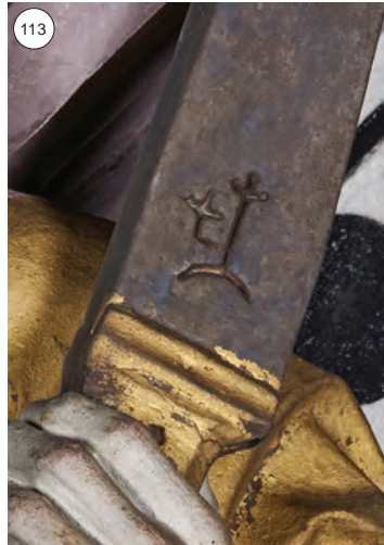
Nr. 70 - Bartholomäus, Schlusszustand 2017 Er ist auch der einzige Schlussstein, auf dem sich ein Bildhauerzeichen befindet.
