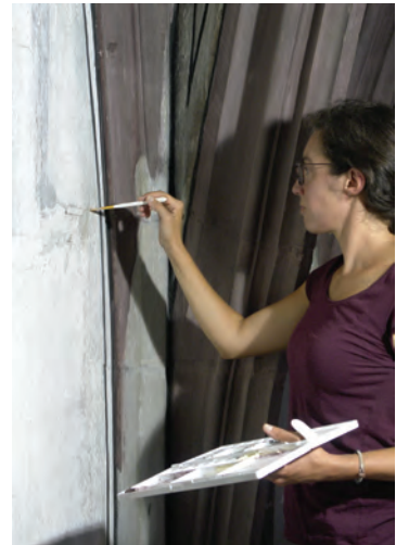
Nach der Trockenreinigung mit Wishab-Schwämmen wurden die gesamten Kappenflächen mit dem Wattestäbchen und klarem Wasser nachgereinigt. Zum Schluss sind wenige störende Fehlstellen (hier an den Wandflächen) in Tratteggio-Technik (Strichretusche) geschlossen worden.
