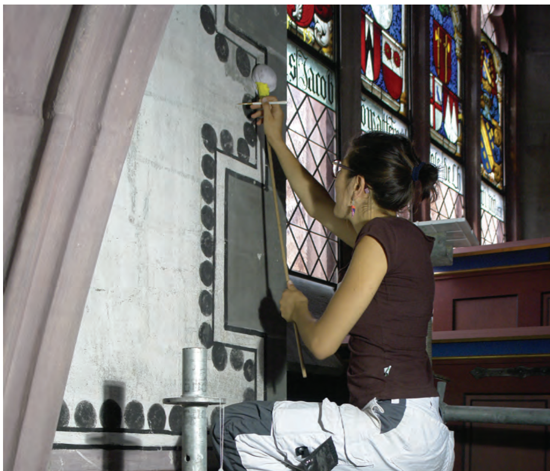
Régine Saucy (o.) und Rowena Pasche (u.) beim Retuschieren der Wandflächen in Strichretuschiertechnik (Strichretusche) auf dem bereits teilweise rückgebauten Gerüst.
