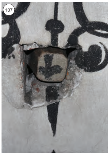
107 Das Holz, im nachträglich durch den Putz gestossenen Abzugslotch, wurde durch die Bemalung in das Ornament integriert, um die Fehlstelle schon 1517 nicht so auffällig wirken zu lassen.
