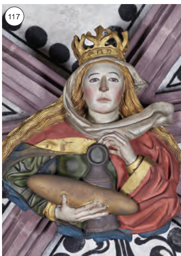
Nr. 33 - Elisabeth, Schlusszustand 2017 Beim Einbau oder besser gesagt beim Versatz der Schlusssteine zeigte sich, dass der Abstand zwischen Skulptur und Rippenanschluss oft zu klein war, um den Stein auf das Lehrgerüst abzusetzen. Das Problem wurde kurzer Hand gelöst, in dem man einfach ein Stück der Skulptur abschlug, danach hatte das Stützholz wieder Platz. Die Fehlstellen wurden später einfach mit Farbe überstrichen.
