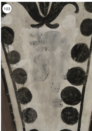
103 An dieser Stelle gibt es unter dem Ornament ein Petimento, ein grosses Symbol oder Zeichen, dessen Bedeutung bisher unbekannt ist. Es wurde gleich wieder mit dickem weissen Kalk überstrichen. Petimento kommt aus dem Italienischen und bedeutet so viel wie „Reue“.
