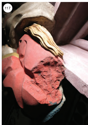
Nr. 33 - Elisabeth, Schlusszustand 2017 Beim Einbau oder besser gesagt beim Versatz der Schlusssteine zeigte sich, dass der Abstand zwischen Skulptur und Rippenanschluss oft zu klein war, um den Stein auf das Lehrgerüst abzusetzen. Das Problem wurde kurzer Hand gelöst, in dem man einfach ein Stück der Skulptur abschlug, danach hatte das Stützholz wieder Platz. Die Fehlstellen wurden später einfach mit Farbe überstrichen.
