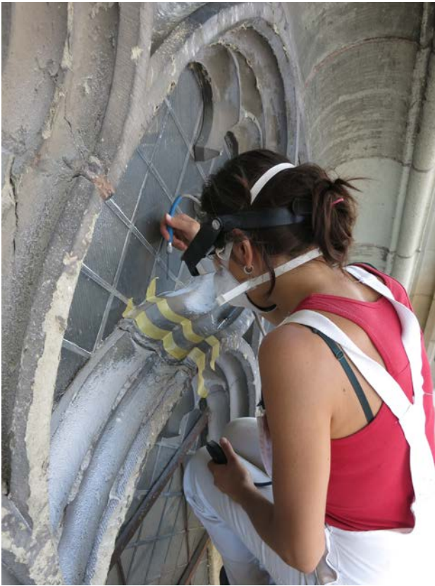
Probereinigung mit dem Mikrosandstrahlgerät.
