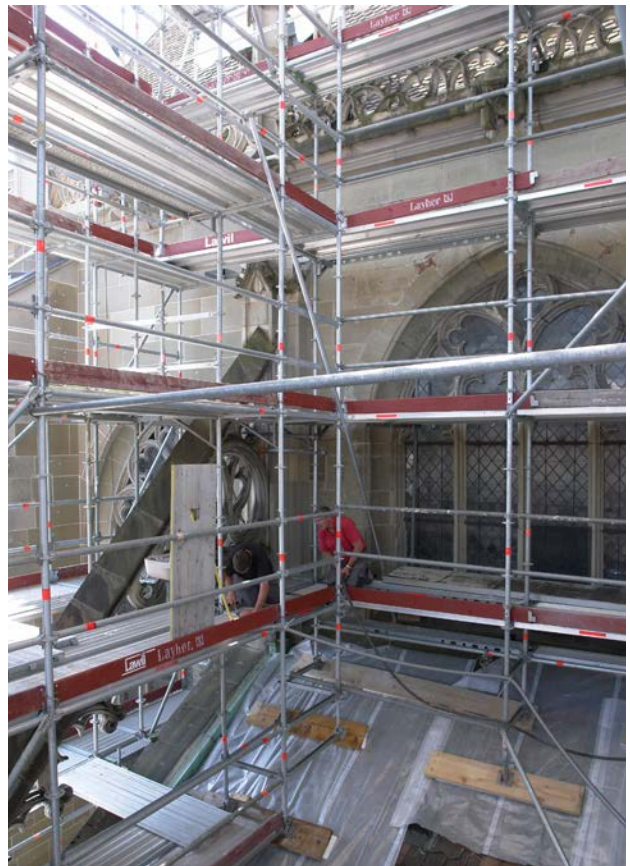
Gerüstbau und Einhausen der Winterbaustellen.
