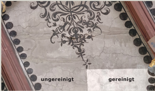
Vor der Reinigung: vermörtelte Risse wurden der grau-lich verschmutzten Gewölbekappenfarbe angepasst
