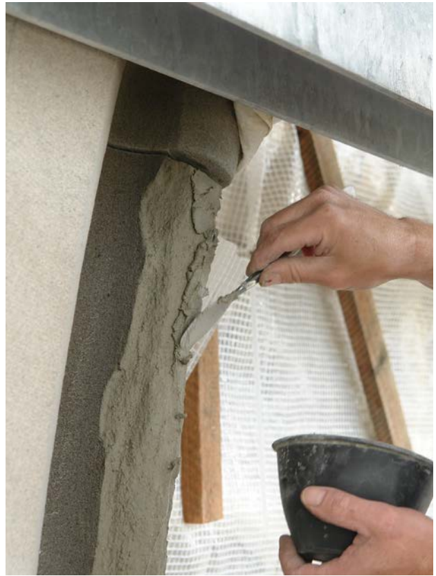
Aufmörtelung statt Steinaustausch.
