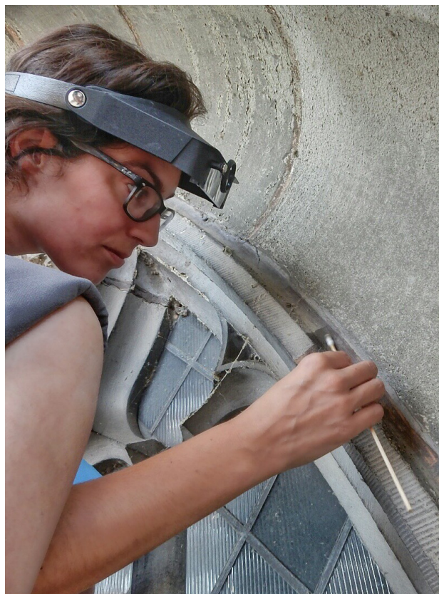
Probereinigung mit Wasser.
