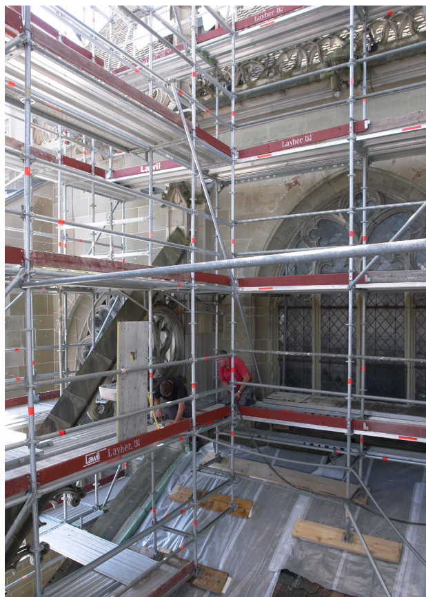
Gerüstbau und Einhausen der Winterbaustellen.
