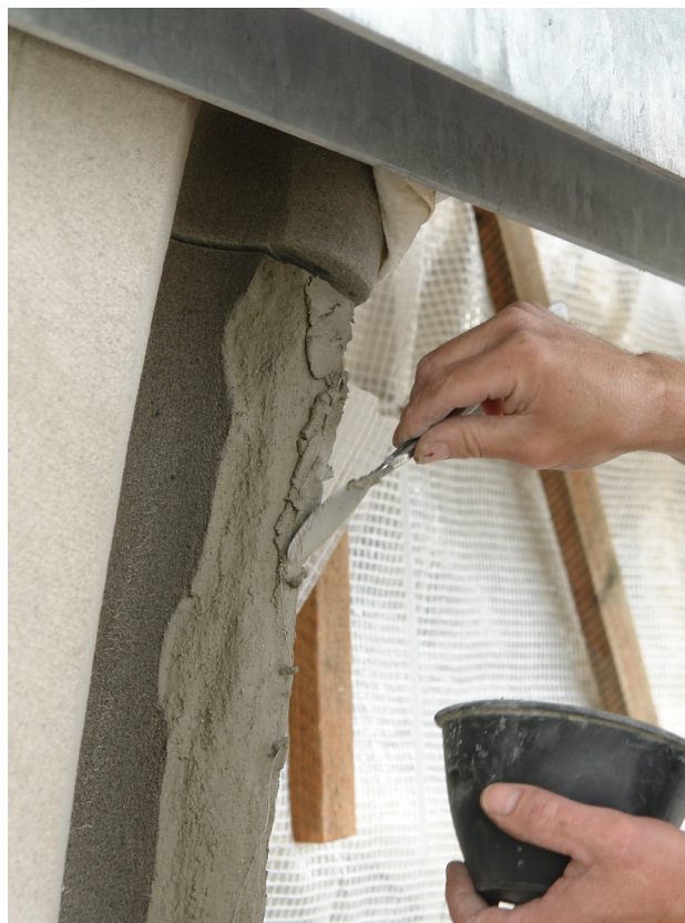
Aufmörtelung statt Steinaustausch.
