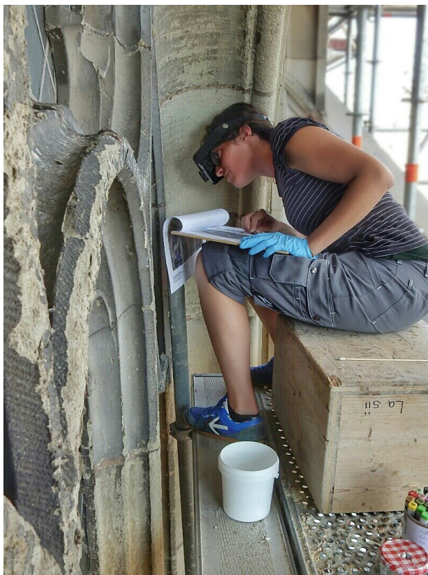
Untersuchung und Kartierung durch die Restauratorinnen der Münsterbauhütte.
