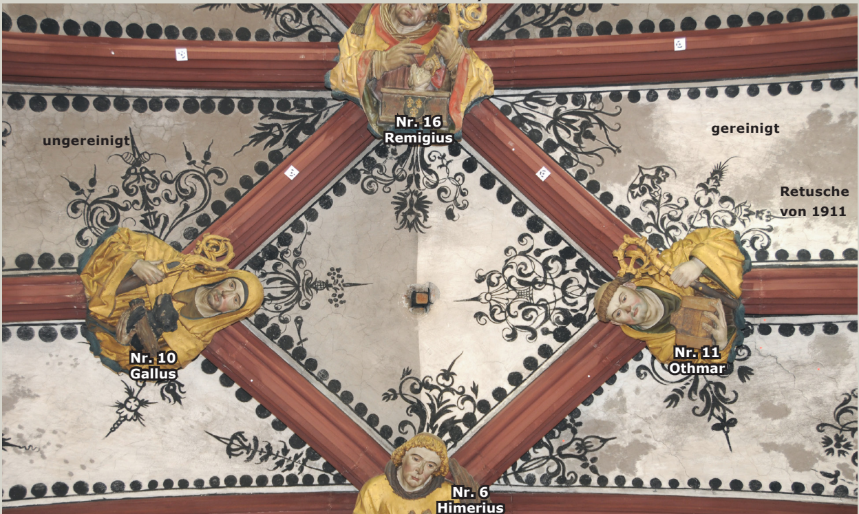
Gewölbekappen ungereinigt (links), gereinigt (rechts): graue Retuschen von 1911 kommen zum Vorschein (Nick Brändli, Zürich)
