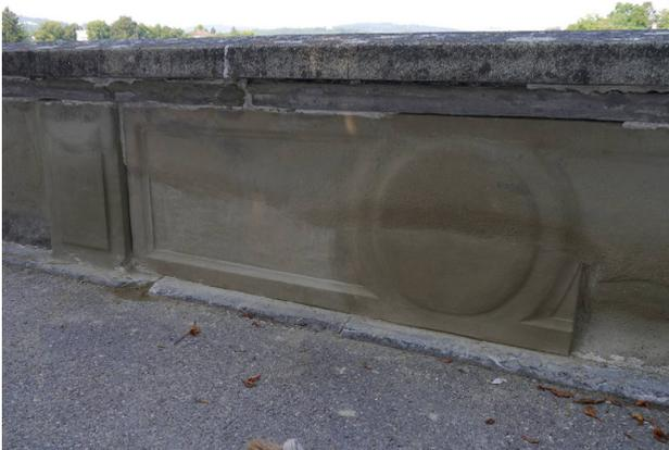
Als eine Hauptursache der Schäden konnte unter anderem das auf der Plattform zur Schneeräumung reichlich verwendete Streusalz nachgewiesen werden. Das Salz ist oberflächlich in die Werkstücke eingedrungen. Die stark versalzene und irreversibel geschädigte Zone hat eine Tiefe von ca. 15-20 mm. Sie muss entfernt werden, kann danach jedoch mit Aufmörtelungen ergänzt werden.
