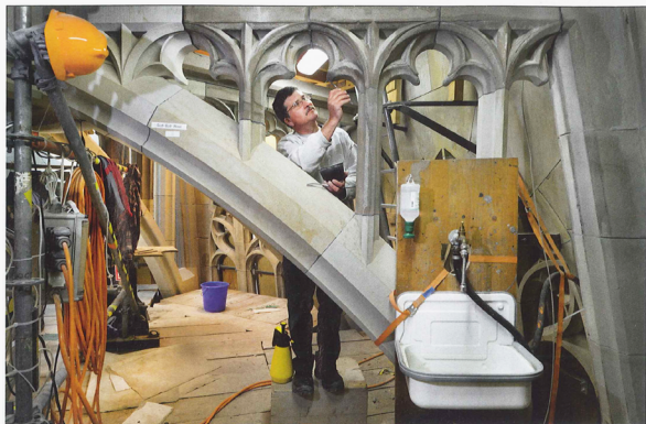
Steinmetz Ulrich Aeschbacher repariert mit Mörtel aus authentischen Materialien abgegrübelte Ecken und Kanten im Strebewerk
