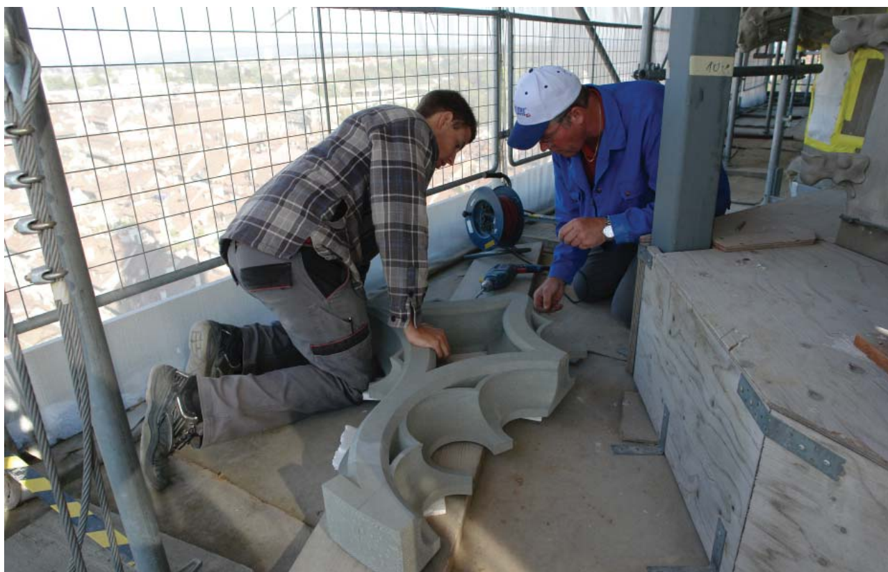
(o.) Anlieferung des neu gefertigten Masswerkstücks auf die Gerüstbasis. Bohren der Dübellöcher.
