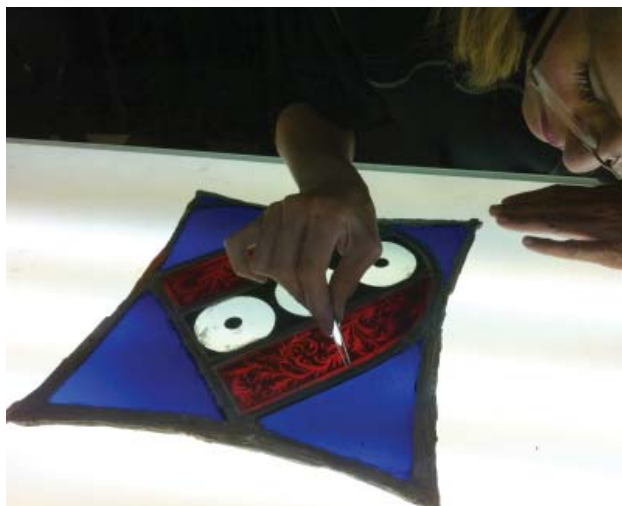
(o.) Vorsichtiger Ausbau der Glasmalereien aus dem Fenstermasswerk. Foto: Glasatelier Stettler, Bern.
