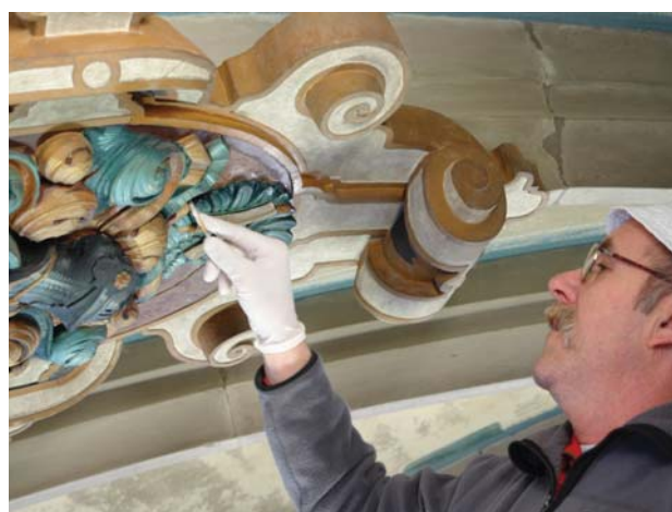
(o.) Rissverfüllung zwischen Gewölberippe und Gewölbekappe.
