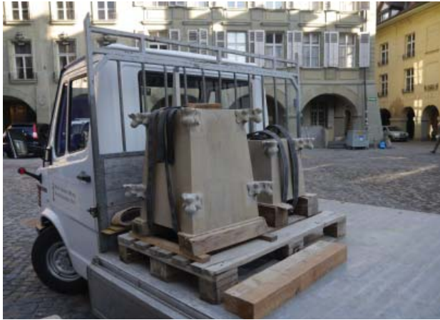
(m.l.) Die noch gut erhaltenen Krabben wurden ausgebaut und später in das neue Werkstück wieder eingesetzt.
