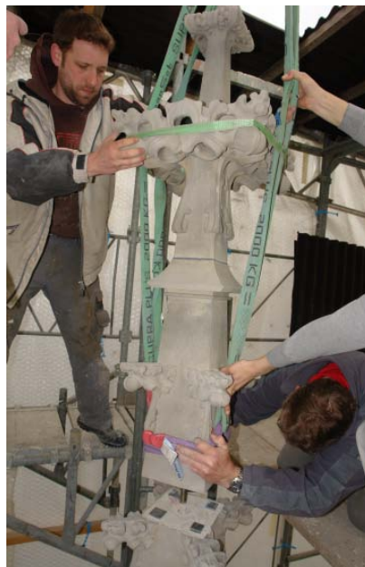
Impressionen vom Aufsetzen und Verbleien von zwei weiteren restaurierten Chorfiolen und der neu gehauenen Schaftstücke. Die einzige noch fehlende Fiale wird im Zuge der letzten Restaurierungsetappe am Chor 2011/12 wieder aufgesetzt.
