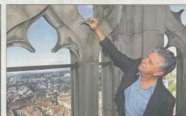
Münsterarchitekt Hermann Häberli führt mit dem in Bern erfundenen Blechkörper vor, wie im Sandstein das Turmhelms verdrängte schaufelartige Stützen aufgespart werden.
