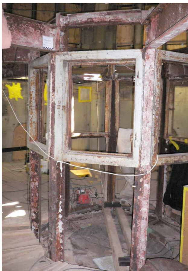
(l.) Zustand der bis 2007 verkleideten Stahlkonstruktion im Turmwatchlokal.
