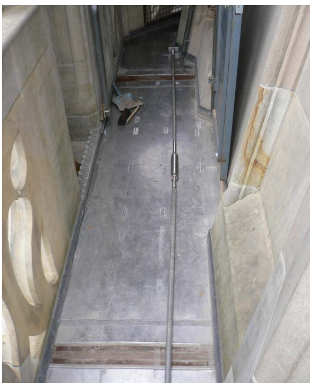
(o.) Montage der Zugstangen auf allen 8 Seiten der Achteckgalerie.
