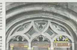
Saniert – nicht saniert: Steinmetze erledigen Detailarbeit.
