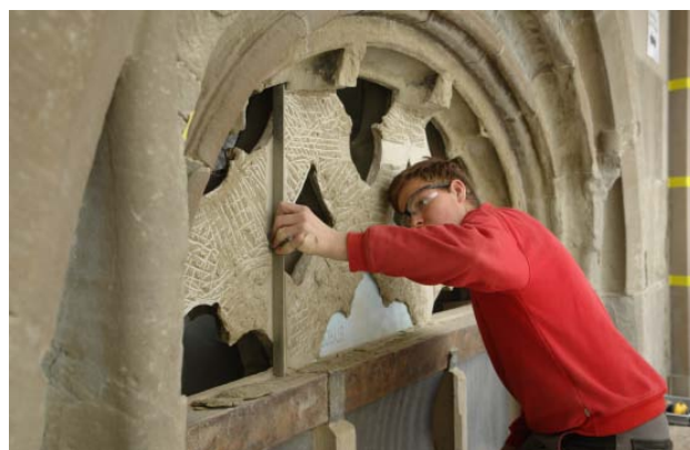
(o. und u.) Vorsichtiger Abbau des äusseren Teils des Masswerks.
