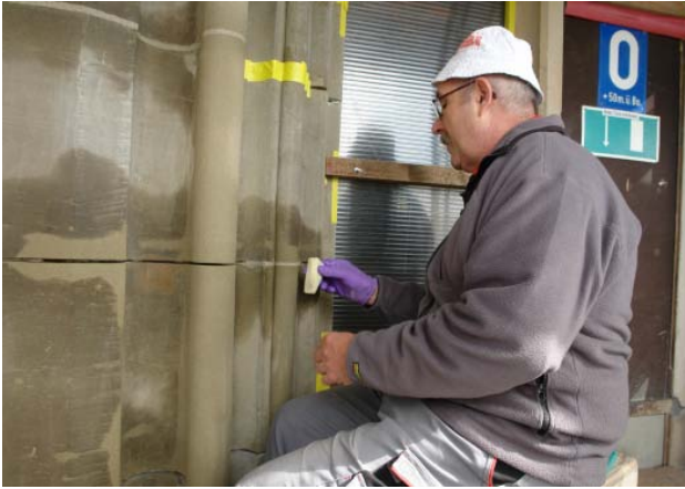
(o.) Aufmörtelungen und Ausfugen an einem Gewände- profil am unteren Achteck Süd.
