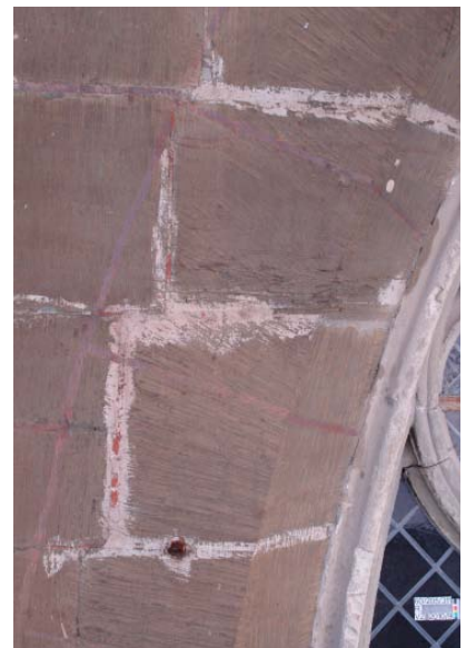
(o.l.) Schadenskartierung mittels Tablet PC auf fotogrammetrischen Plänen.
