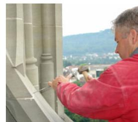
Nebst der detaillierten Überprüfung wurden dringendste Pflegemassnahmen durchgeführt. An einigen beschädigten Fugen, besonders an Stellen, die durch Schlagregen stark bewittert sind, wurden die Fugenmörtel ausgetauscht. Dabei kam ein Sumpfkalkmörtel auf Grundlage einer Rezeptur von Urs Zumbrunn zur Anwendung, welcher seit 2004 für Fugen am Achteck verwendet wird.
