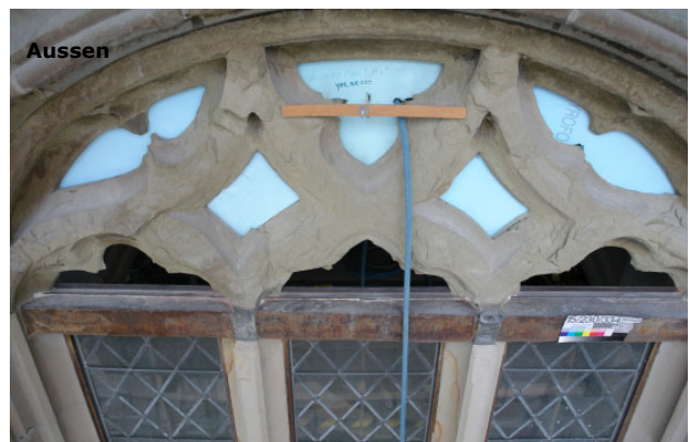
(o.) Fenstermasswerk West, um 1520: Obwohl im Aussenbereich fast komplett zerstört, befindet sich die innere wettergeschützte Masswerkhälfte in tadellosem Zustand.
