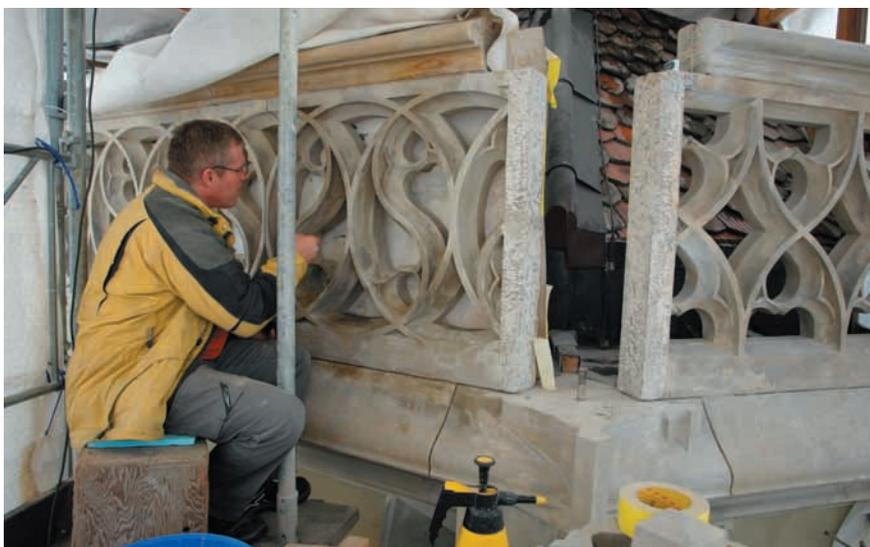
links: Aufmörtelung der Brüstungen nach erfolgter Reinigung.
