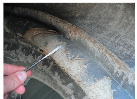
Entnahmestelle der Probe Südwest (hier Probe 2SW). Oben Übersicht, unten Detail.
