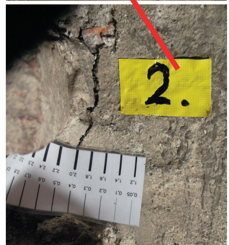
Kontrolle der Risse in den Gewölbekappen auch von oben (Blick aufs Gewölbe).
