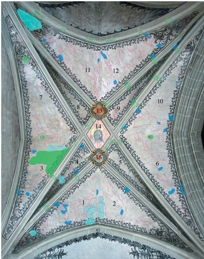
links: Kartierung der Risse und Schalen im Gewölbe des südlichen Seitenschiffes, Höhe Lombachkapelle, durch Urs Zumbrunn, 2009.
