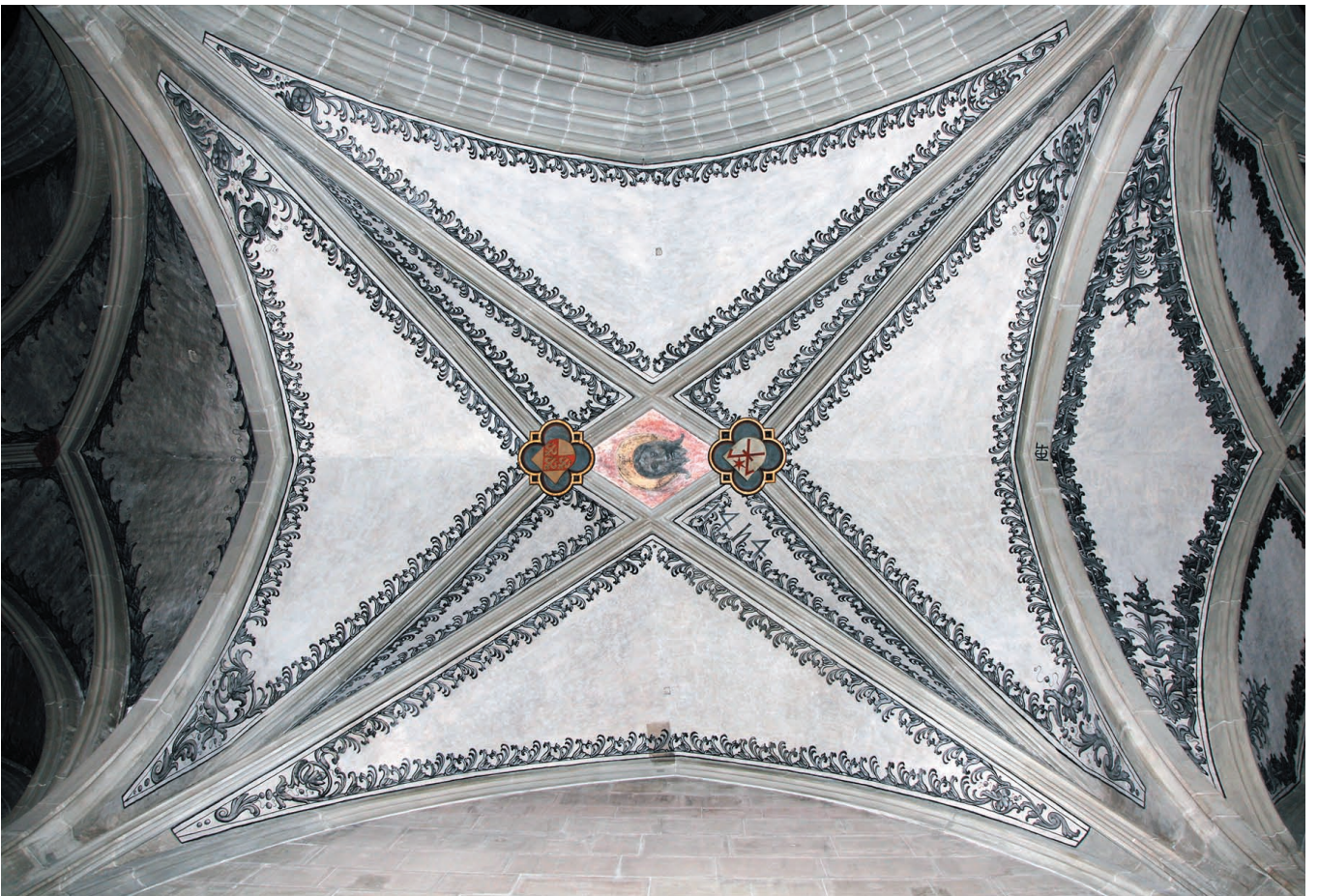
Gewölbe der Lombachkapelle (Seitenschiff Feld 60 Süd). Oben: Vorzustand September 2009, unten: Schlusszustand nach erfolgreicher Restaurierung April 2010 (beide Fotos: Urs Zumbrunn, Restaurator HFG).
