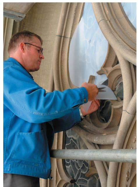
links: Detail der noch originalen Einbausituation im Masswerk des Mittelfensters. Unten im Bild ist das Prinzip der Schutzverglasung von 1947 gut erkennbar. Rechts: Schutz der an Ort verbleibenden Masswerkscheiben durch die Münsterbauhütte vor Beginn der Arbeiten im Aussenbereich.
