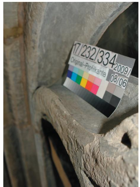
rechts oben: Sichern von aufgebrochenen Kanten im Masswerk.
