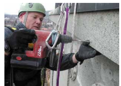
Bohren von Armierungen
