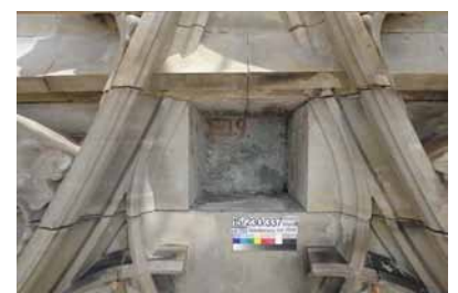
links: Risse und offene Fugen an der Südwest-Ecke des Turmachteckes / rechts oben: Zur Überwachung allfälliger Bewegungen wurden an der Südwest-Ecke Rissmarken gesetzt / rechts unten: Sondierung an der vermuteten Position des Ringankers unter der obersten Besuchergalerie
