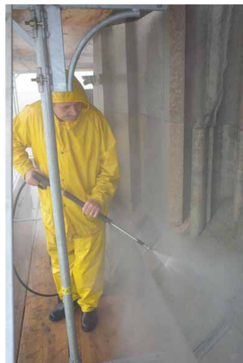
Nassreinigung am oberen Achteck
