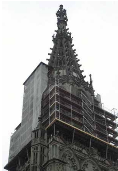
Abbau Ost und Aufbau West
