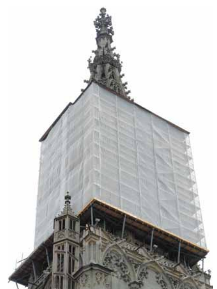
Westseite fertig eingerüstet
