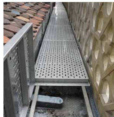
Optimierter Ausführungsvorschlag mit möglichst leicht aufdeckbaren Lochblech-elementen auf freistehender Unterkonstruktion. Ganze Konstruktion rostfrei. Skizze: Heinz Wyss, Ramseyer + Dilger AG, Bern
