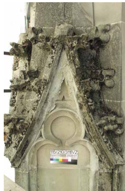
Angetroffener Zustand des Wimperges am Pfeiler 115
