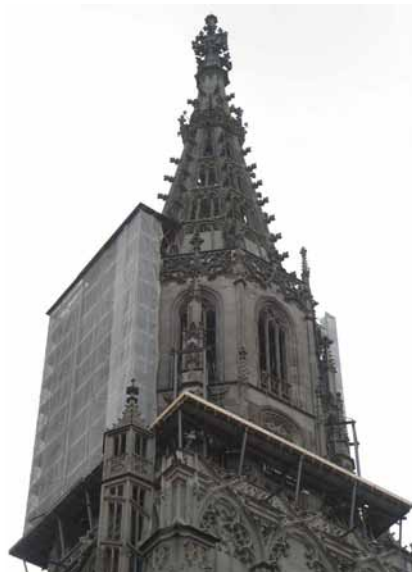
Gerüstbasis West erstellt
