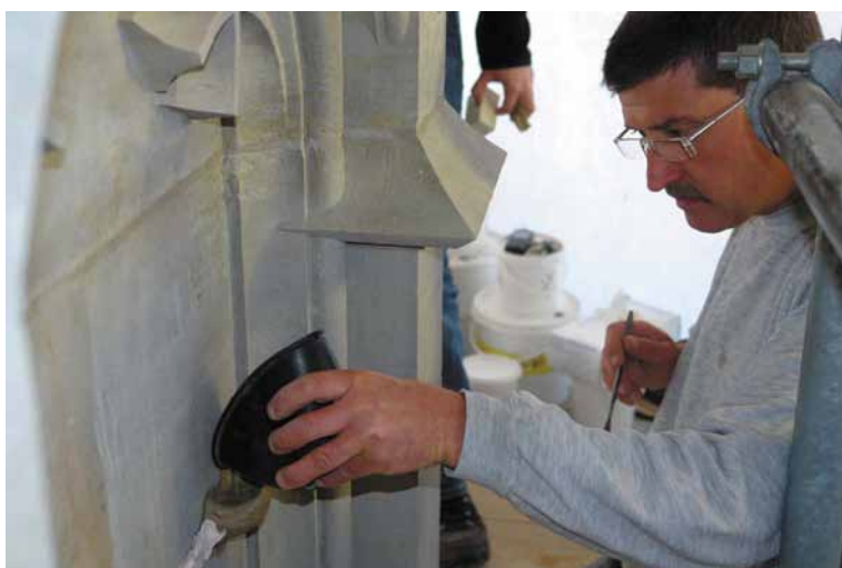
Riss- und Fugensanierung Südwestfiale
