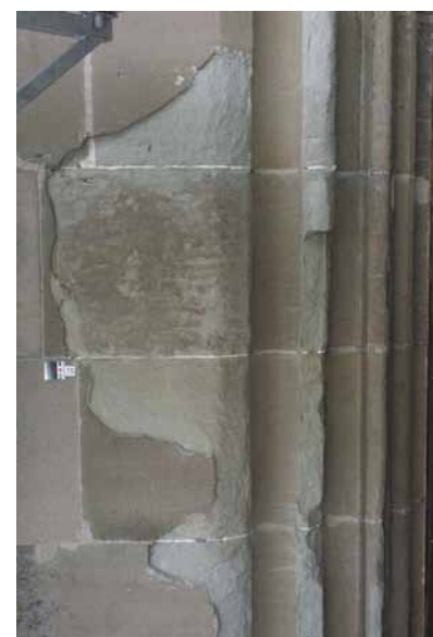
Wandfläche in Berner Sandstein am unteren Achteck West.
