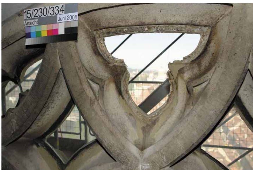
Das Fenstermasswerk an der Westseite innen ist abgesehen von Verschmutzungen völlig intakt.
