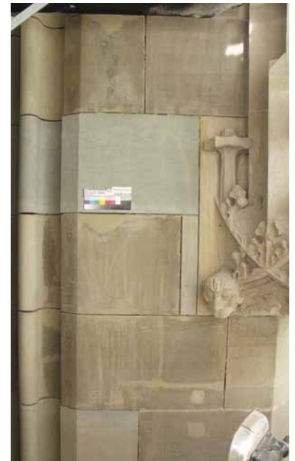
Fertig restauriertes, noch nicht ausgefugtes Fassadenstück an der Südostseite (Werkstück hinter Verortungsschild: Natursteinersatz)
