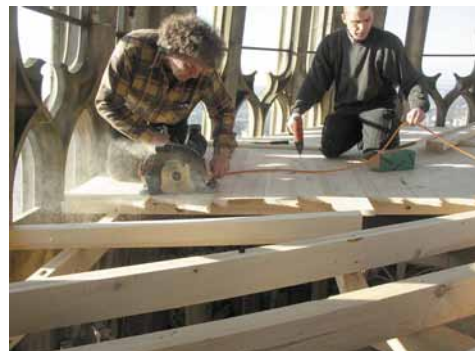
Zimmermannsarbeit auf Mass
