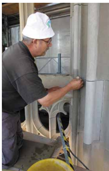
Ausfugen nach dem Versetzen und Aufmörteln
