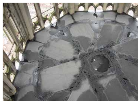
Abdichtung des Schutzdachs im Turmhelm
