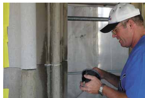
Aufmörteln an der Nordseite
