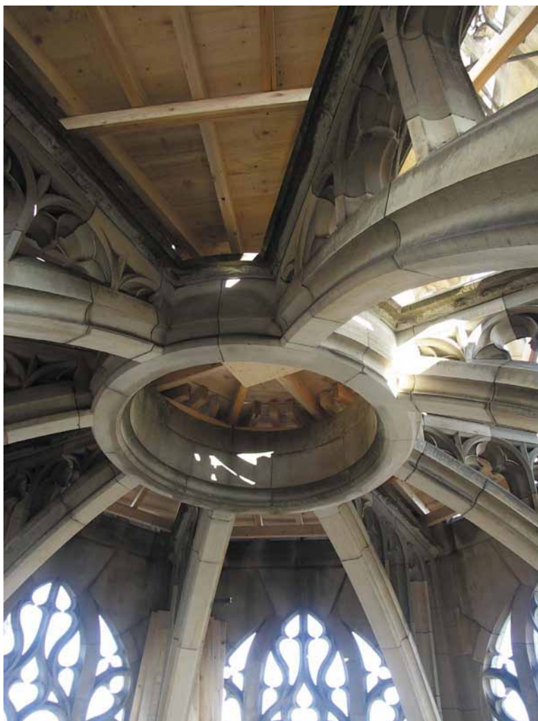
Ansicht des Notdaches über dem Turmwachtgeschoss von unten. Das Notdach wird das weiter unten liegende Gewölbe des Haspelbodens bis auf weiteres vor Wassereintrüben schützen
