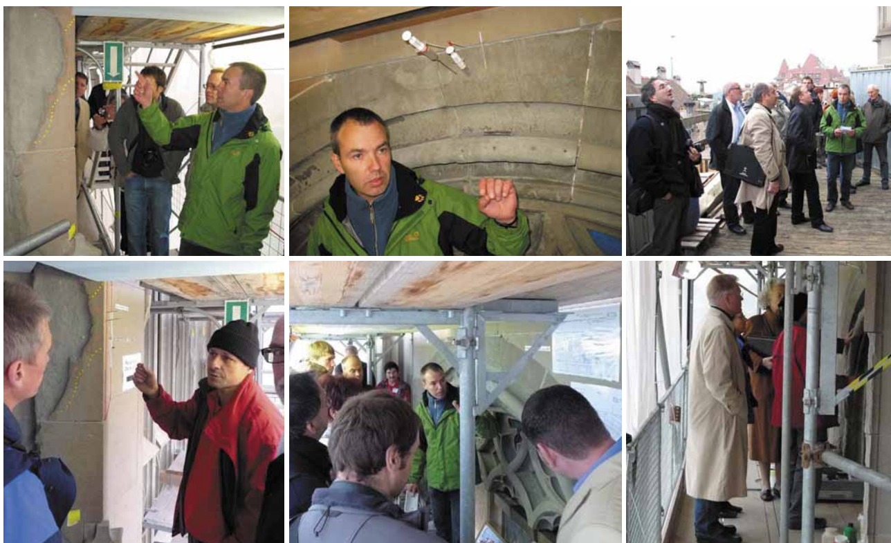
An Führungen durch offene Baustellen konnten bis hoch in die Turmbaustelle umfangreiche Einblicke in die Arbeiten an der Front sowie hinter den Kulissen gewährt werden Fotos obere Reihe: Kirchenbaurat G. Püschmann (Dom Zwickau)
