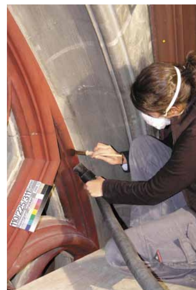
Behutsame Reinigung der bemalten Steinoberfläche
