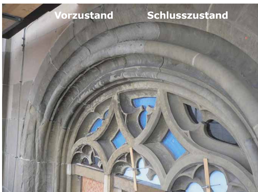
Zur Hälfte restauriertes Masswerk (Vorzeigeobjekt für Tagung)
