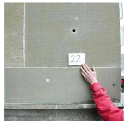
oben: Bohrkernentnahme am Objekt
