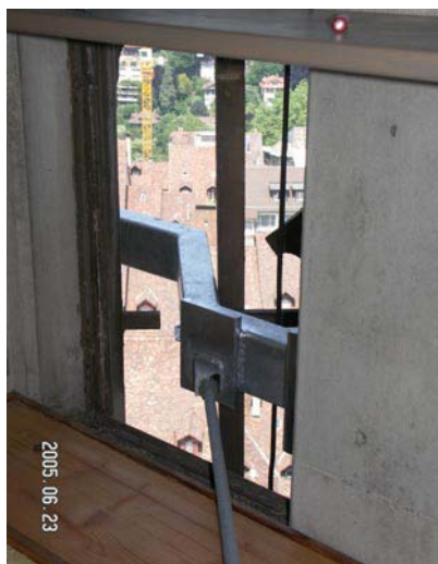
Der Ringanker: Links fertig montiert und mit Holz unterlegt. Mitte: Detail mit über den Boden der Turmstube gespannter Zugstange. Rechts: Verschweissen der vorproduzierten Teile auf der unteren Besuchergalerie
