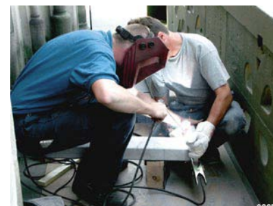
Der Ringanker: Links fertig montiert und mit Holz unterlegt. Mitte: Detail mit über den Boden der Turmstube gespannter Zugstange. Rechts: Verschweissen der vorproduzierten Teile auf der unteren Besuchergalerie
