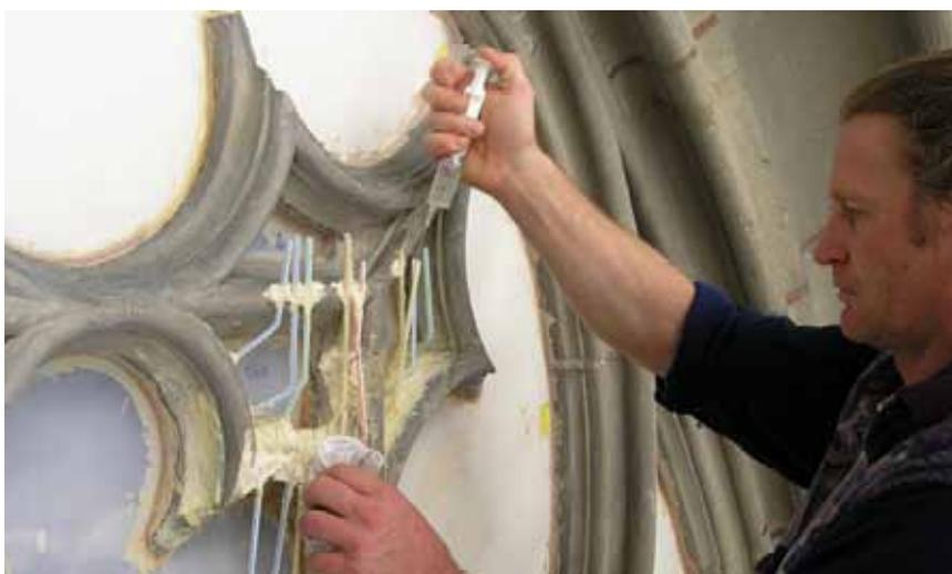
Die absturzgefährdeten Teile wurden mit feinen Chromstahlgewindestangen armiert, bestehende Verstärkungen mit Stützen und Streifen aus Chromstahl ergänzt. Einige Sicherungselemente haben nur präventive Wirkung. Diese nehmen zum heutigen Zeitpunkt keine Lasten auf, können aber bei weiteren Gebäudesetzungen oder anderen Beeinträchtigungen der Substanz den Absturz von Bauteilen verhindern.
