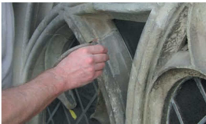
Fenster 80 Nord, über Schultheisenpforte: Reduktion schwarzer Krusten mit dem Mikrosandstrahlgerät. Aufgrund möglicherweise noch vorhandener Farbspuren erfordert diese Methode höchste Konzentration und Fingerspitzengefühl.
