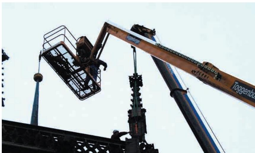
Abbau von fünf Chorfialen mit dem Pneukran und Zwischenlagerung auf der Münsterplattform. Die Chorfialen werden anschliessend in die Bauhütte gebracht, wo sie während des Winters restauriert werden sollen (vgl. nächste Seite).
