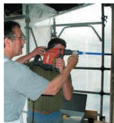
Für die Analyse wird eine Bohrprobe entnommen.
