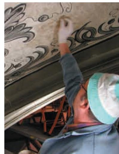
oben: In minutiöser Kleinarbeit werden die Gewölbekappen von Staub und Russ befreit. Die kreidenden Malschichten werden gefestigt und partiell retuschiert.
