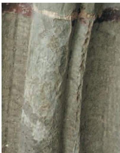
Detail Fenster 90 Nord: Reduktion von Oberflächen durch vorsichtiges Zurückkleben von aufgebrochenen Steinschollen mit Kieselsäure-dispersion (links vorher, rechts: nachher)
