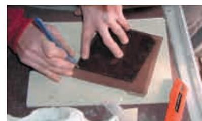
Gemäss dem aktuellen Restaurierungskonzept der Berner Münster-Stiftung werden Rautenverglasungen direkt an Ort ergänzt. Wie der Stein wird auch die Bleiverglasung möglichst nicht mehr oder nur partiell ausgebaut.
