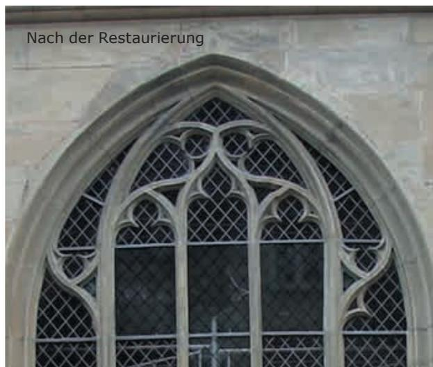
Das Fenster 70 am nördlichen Seitenschiff wurde 2004-2005 ebenfalls durch die Münsterbauhütte an Ort restauriert, diesmal ohne jeglichen Steinersatz. Der angetroffene Zustand war bei beiden Fenstern 50 und 70 vergleichbar. Die Profile der Obergadenfenster sind allerdings generell wesentlich grösser und somit stabiler als diejenigen der Seitenschiffenster (links: Vorzustand/rechts: restauriert).
