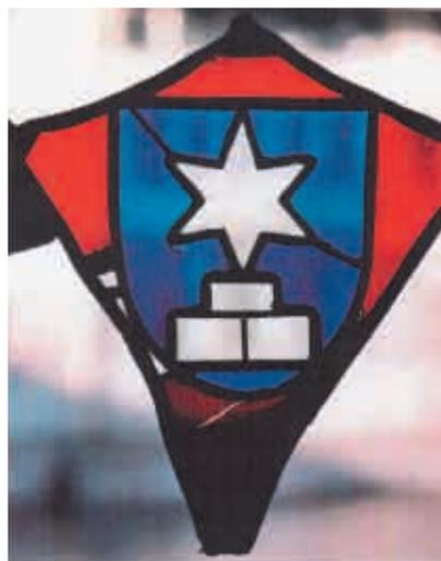
oben: Die Restaurierung des Fensters 80 Süd stand unter besonderer Erschwernis, da eine Glasrestaurierung von 1970 auf Glas und Stein unsorgfältige Verkittungen hinterlassen hatte. Die in grossen Mengen vorhandenen Kittresten erforderten eine sorgfältige Reinigung von Stein und Glas und die Ergänzung verschiedener Glasfelder.
