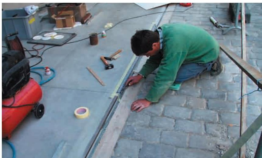
links/unten: Durch den Missbrauch der Portalvorhalle als Wendeplatz entstanden bald nach der Eröffnung Schäden am neuen Boden. Zum Schutz der empfindlichen Kante montierte die Münsterbauhütte einen Chromstahlwinkel.
