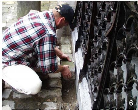
Anstelle des defekten bestehenden Schachtdeckels wurde als Winterarbeit ein neuer Deckel aus Stein gehauen und in eine Bodenplatte eingelassen:
