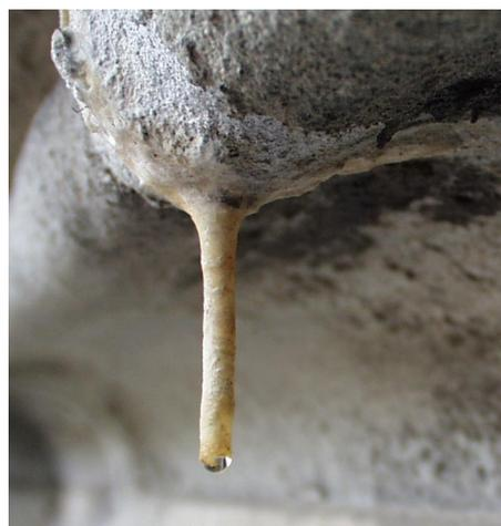
Tropfstein an der Westfassade: Dank der in Arbeit befindlichen Abdichtung der Galerien mit Bleikänneln wird das Eindringen von Wasser in das darunter liegende Mauergefüge bald der Vergangenheit angehören.
