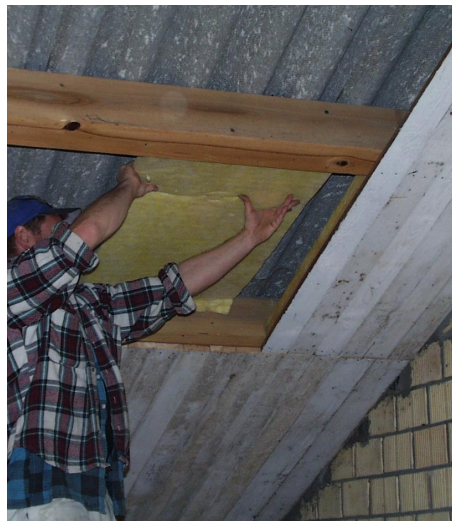
Isolieren des Dachs über der ehemaligen Garage
