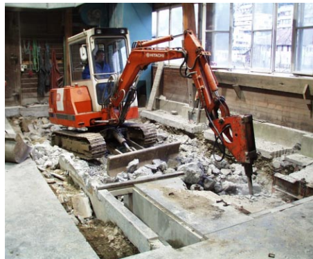
Ausbrechen der alten Fundamentplatte
