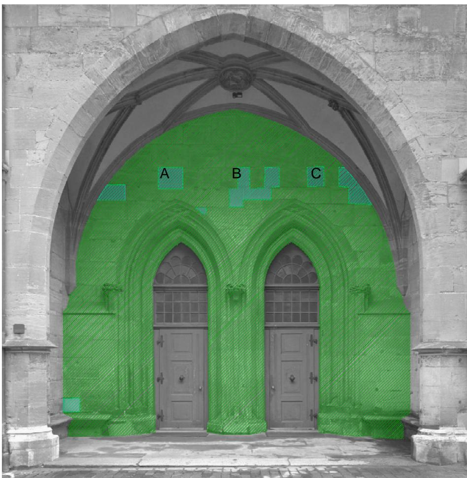
Im oberen Bereich der Frontwand (A, B, C) sind einige Steine offensichtlich ausgewechselt und in weicherem Stein ersetzt worden (schon aufgrund der stärkeren Schäden durch Absanden ersichtlich). Die Vermutung liegt nahe, dass sich hier einmal Baldachine (analog zum Nordportal Ost) über den Figurensockeln befunden haben, welche während des Bildersturms entfernt worden sind. Spuren von alten Befestigungen lassen Rückschlüsse auf hier einmal vorhandene Skulpturen zu.
