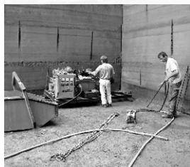
Abbau mit Schrämmaschine
