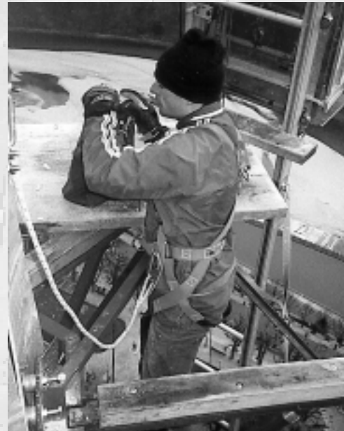
Links: Dokumentation Rechts: Abbau Gerüst
