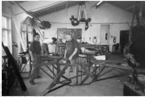
Probelauf Gerüst in der Werkstatt des Schlossers zusammengebaut
