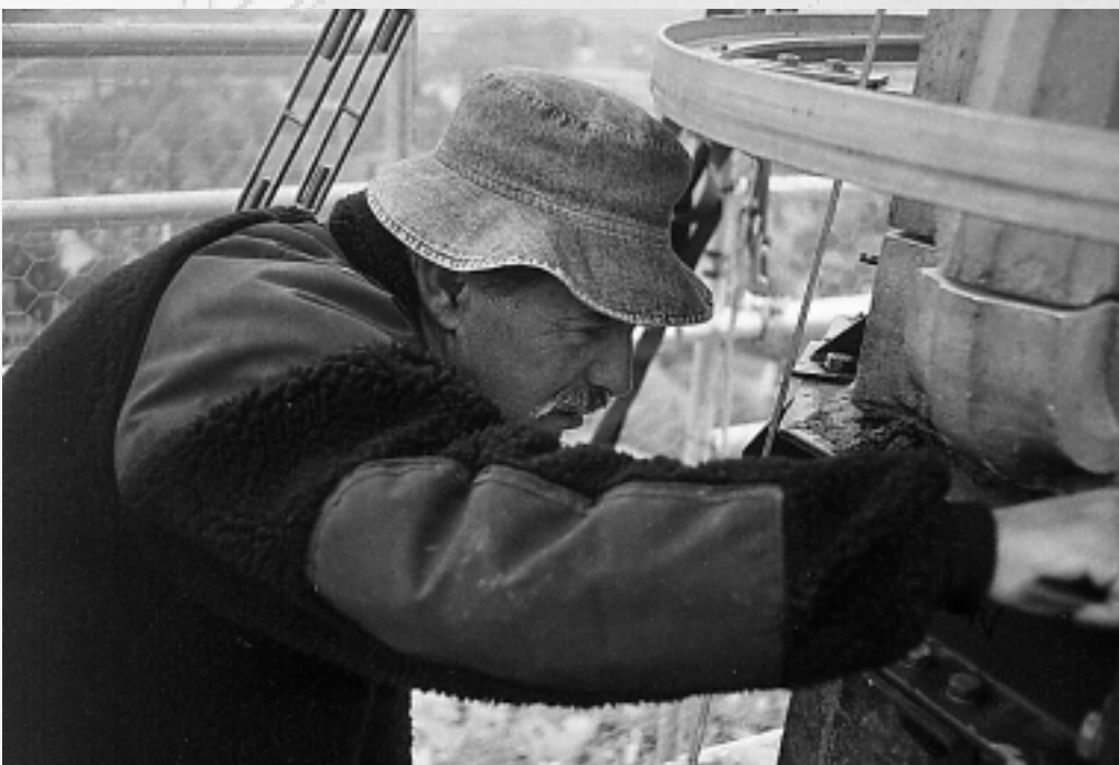
Abdichtung neue Sicherungsmanschette
