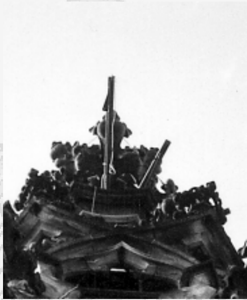
Links: Montage Gerüstboden
