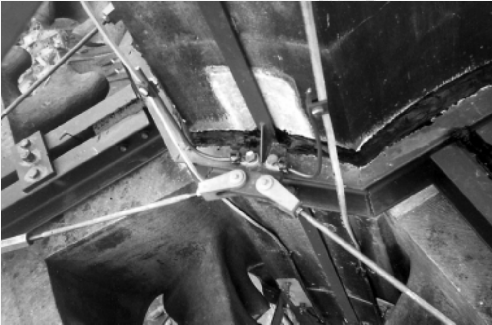
Untere Sicherungsmanschette abgedichtet. Gut sichtbar horizontale Aussteifung
