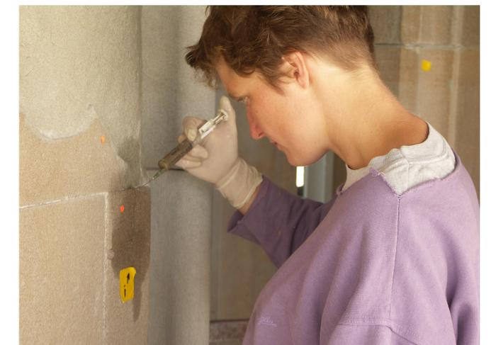
Oberflächliche Risse können direkt mit Spritze und Kanüle verfüllt werden. Durch das Einfärben des Mikrozements mit Pigmenten sind die verfüllten Risse anschliessend kaum noch sichtbar.
