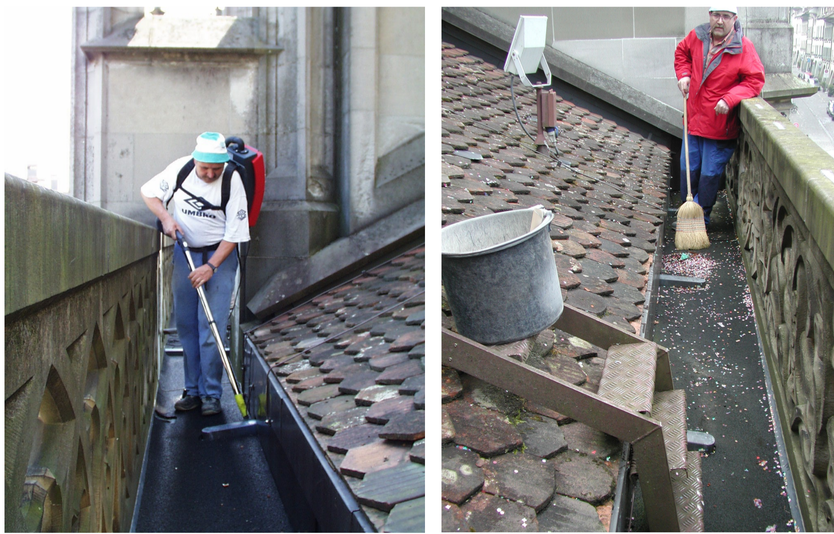
Um einen Verschluss der Ablaufrohre durch Blätter, Papier, Moos etc. zu verhindern, wurden auch in diesem Jahr vor und nach heftigen Regenfällen die Galerien mit einem neu angeschafften portablen Staubsauger vom Unrat gesäubert. Entsprechend den Wetterverhältnissen erfolgen jeweils umgehend Kontrollen. Im Winter werden Dach- und Galeriebereiche von Schnee und Eis befreit. Die Unterhaltsarbeiten erfolgen je nach Bedarf selbständig durch den zuständigen Mitarbeiter der Münsterbauhütte.
