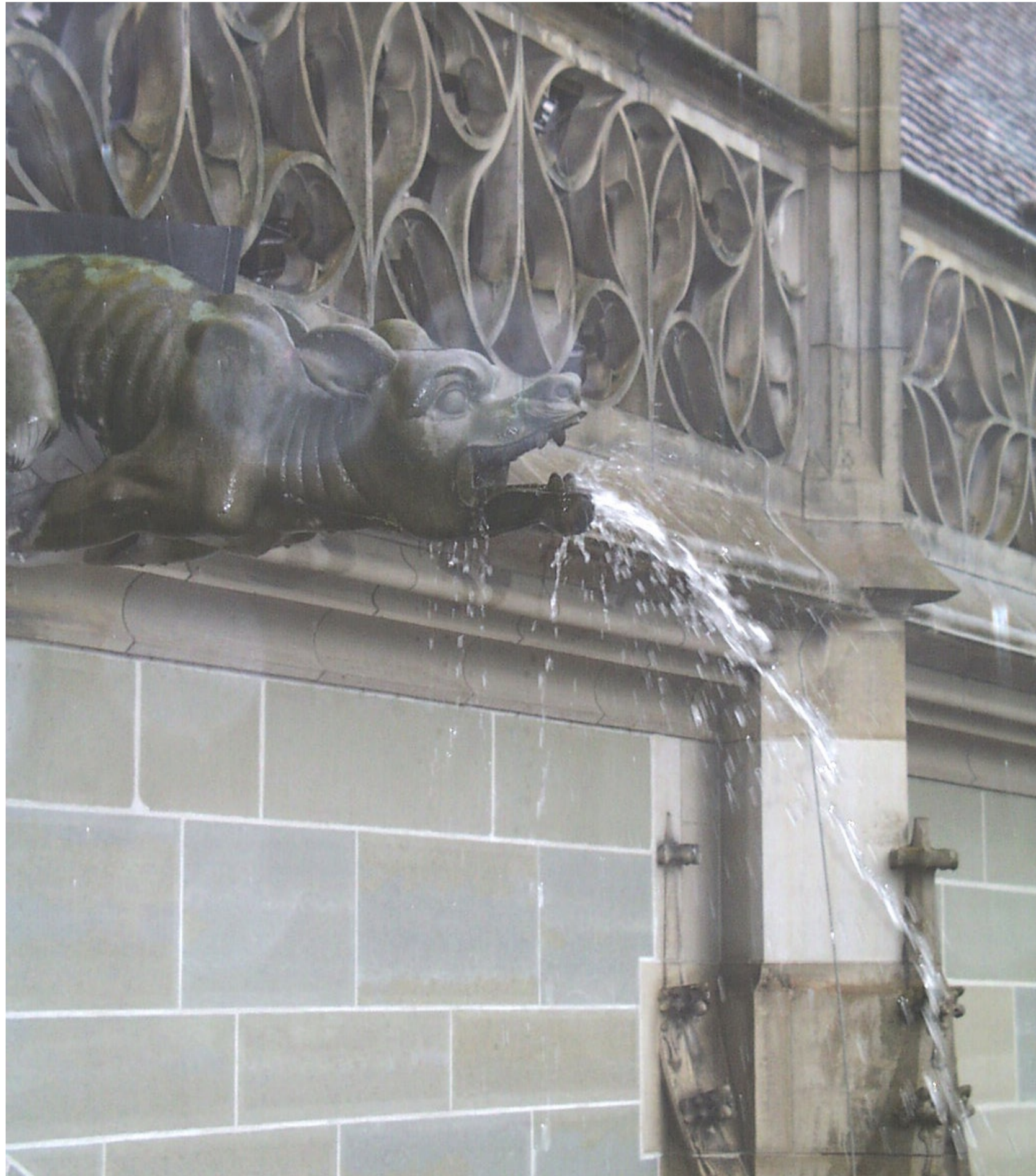
Ein wichtiger Teil des laufenden Bauunterhaltes besteht in der periodischen Baukontrolle, z.B. bei oder direkt nach starkem Regenwetter. Die vielfältigen, situationsbedingten und unspektakulären Massnahmen helfen Bauschäden vorzubeugen.
