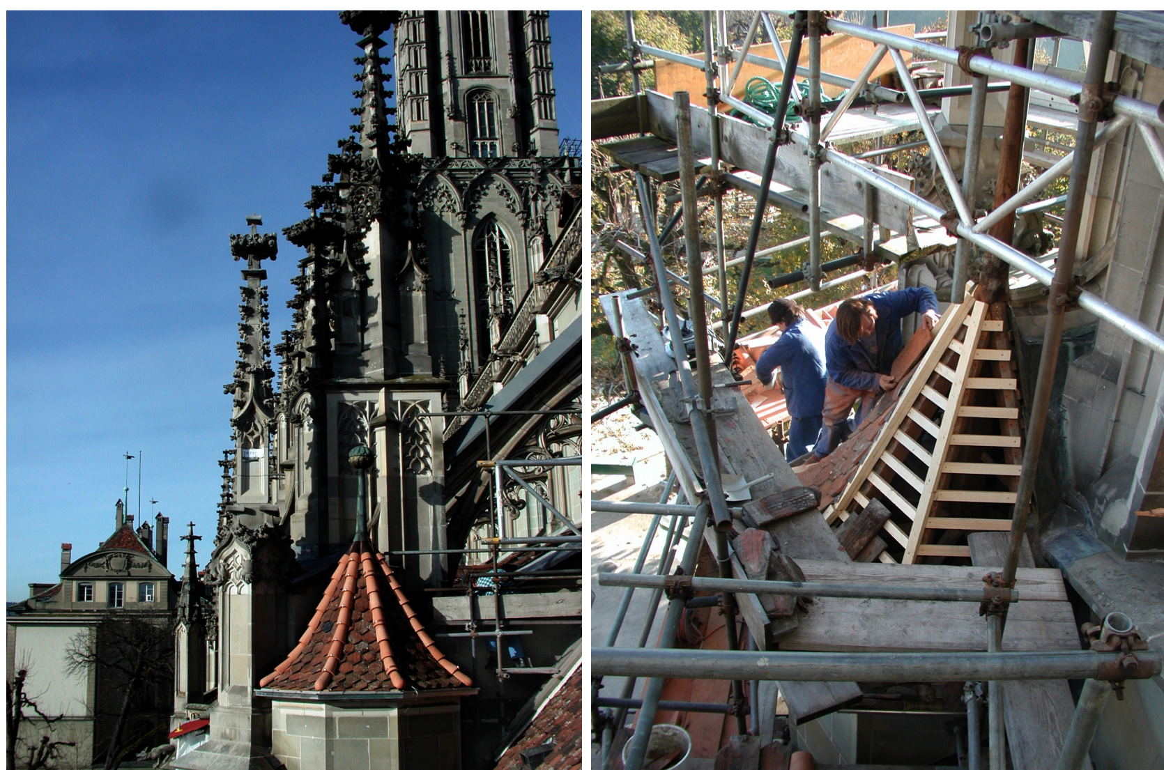
2003 wurde das seit längerem undichte Dach des Sakristeitrepptürmchens saniert. Die Ziegellattung samt Unterdach wurde grösstenteils ersetzt. Die noch brauchbaren alten Ziegel wurden umgedeckt, die First- und Gratziegel ersetzt. Neu wurde eine kleine Dachrinne, welche das Wasser hinten in die darunterliegende Galerie abführt angebracht. Am Schluss wurde das Dach an den Blitzschutz angeschlossen
