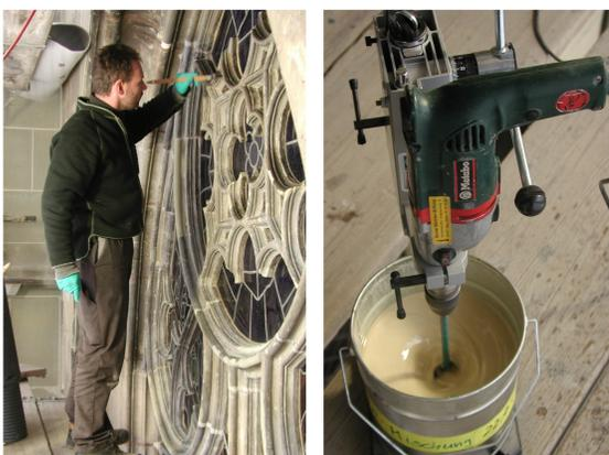
Aufgrund der Befunde an der Fassade der Erlach-Ligerz Kapelle (siehe rechts) wurde das Masswerk nach Abschluss der Restaurierungsarbeiten an dieser Stelle neu geölt (Halböl, Leinöl-Terpentinöl mit minimalem Bleiweisszusatz).
