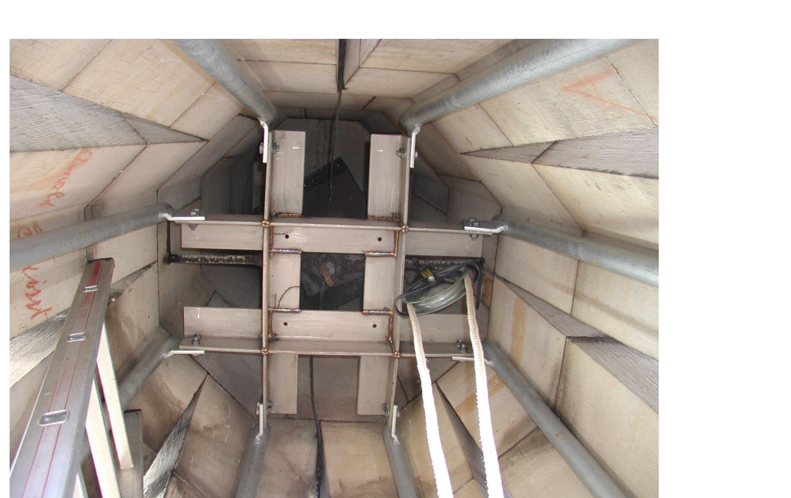
Auffangkonstruktion unter Gegengewicht.
