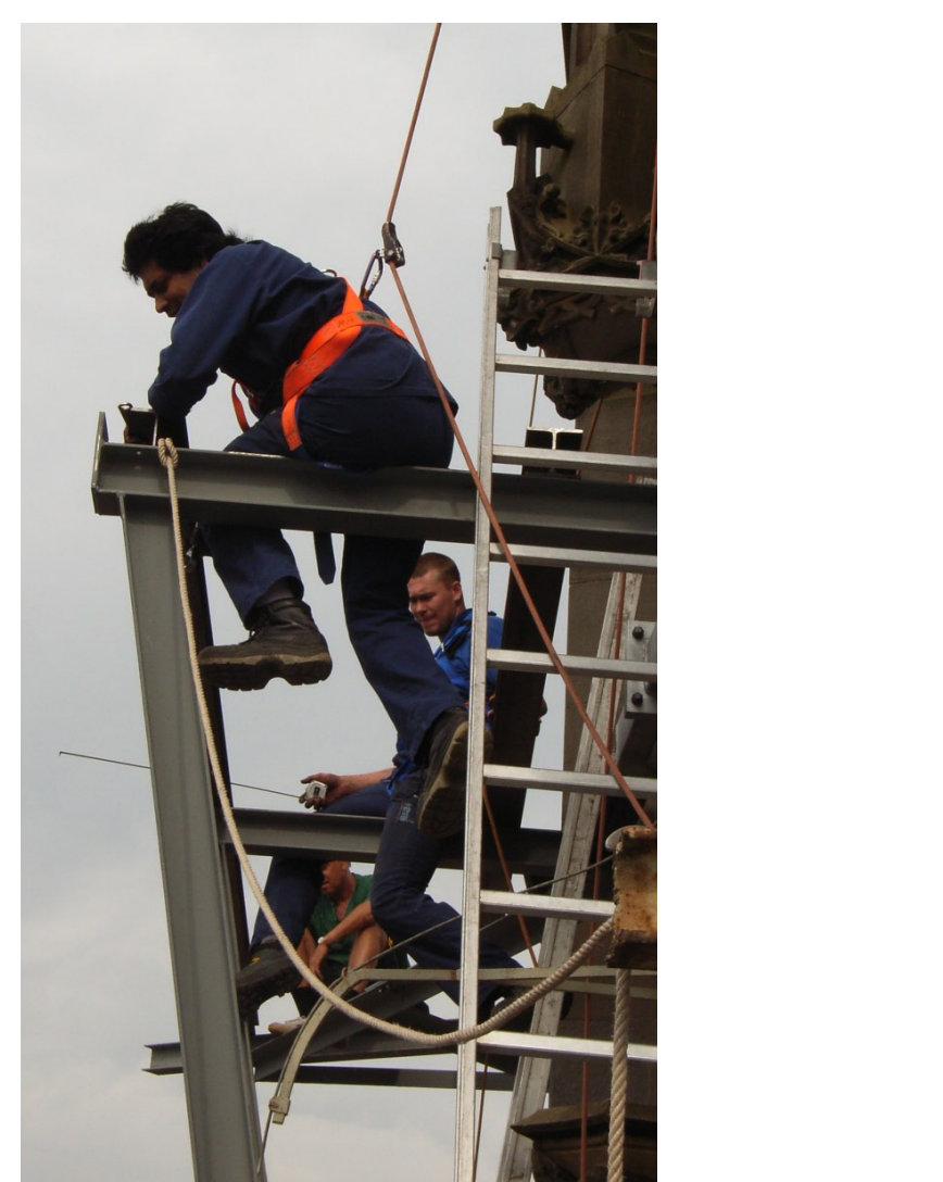
Sicherung von Personen während der Gerüstarbeiten am Turmktogon.
