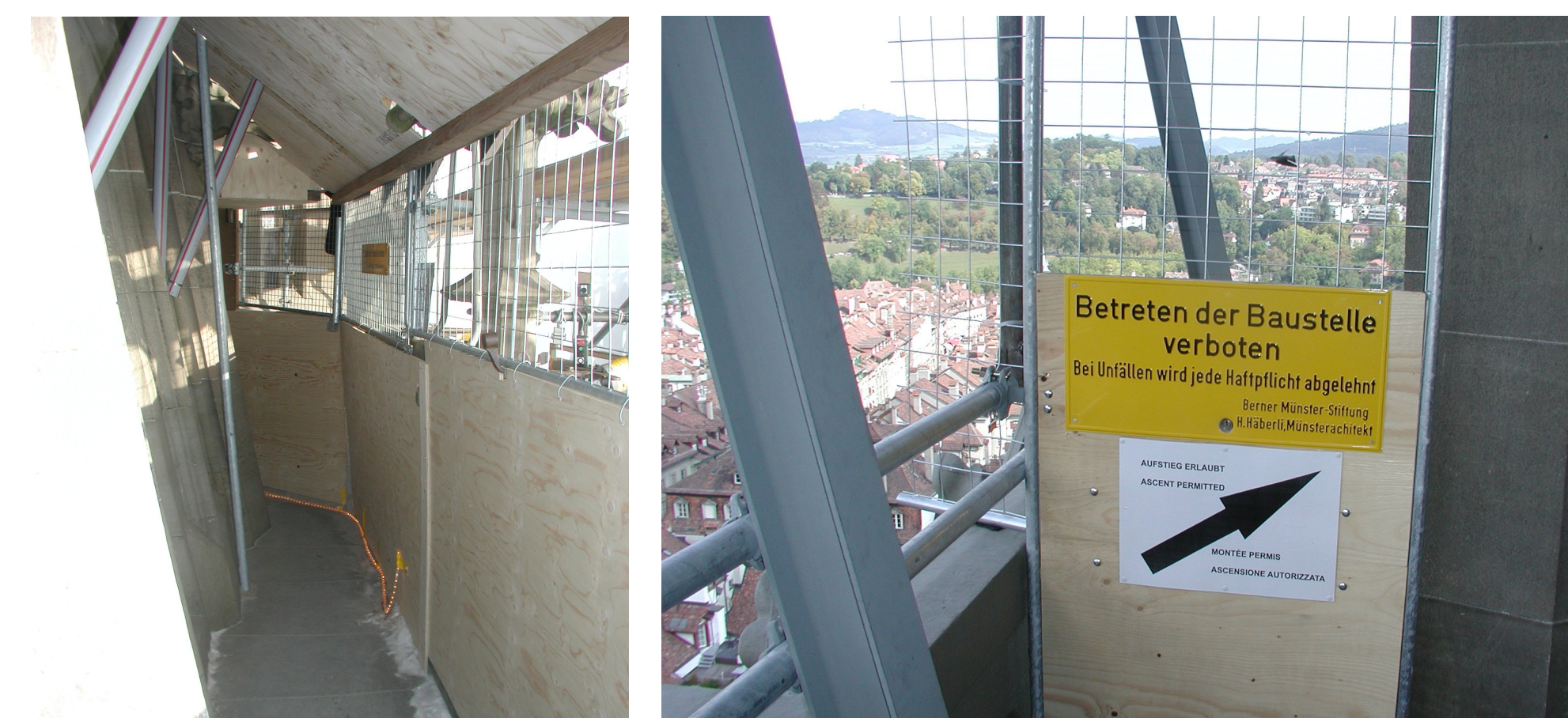
Vandalensicherheit am Turmgerüst. Vor dem Verlassen der Baustelle wurden sämtliche den Besuchern zugängliche Bereiche möglichst vandalensicher abgeschottet. Zusätzlich werden auch über den Winter mehrmals pro Woche Kontrollgänge auf dem Gerüst durchgeführt. Kompromiss: Gewährleistung von Ausblicken für BesucherInnen vom Turm bei beiden Besuchergalerien.
