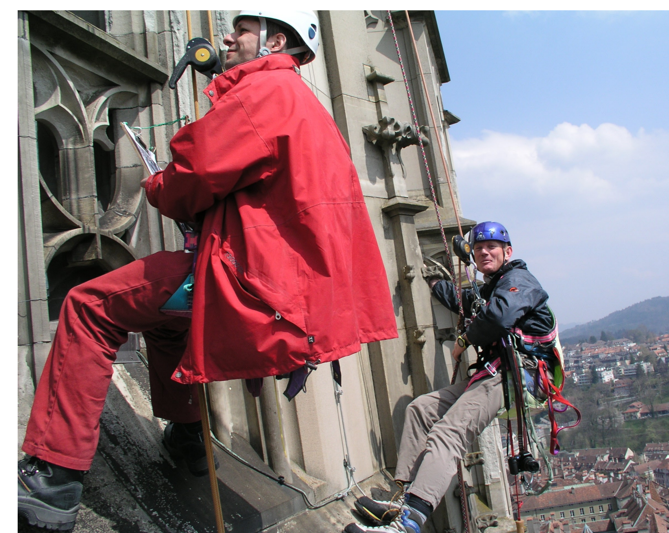
Routinemässige Turmhelmskontrolle im Sommer 2005, zur Sicherheit der Besuchergalerien, im Seil. Unter Leitung von Bergführer Urs Steiner.
