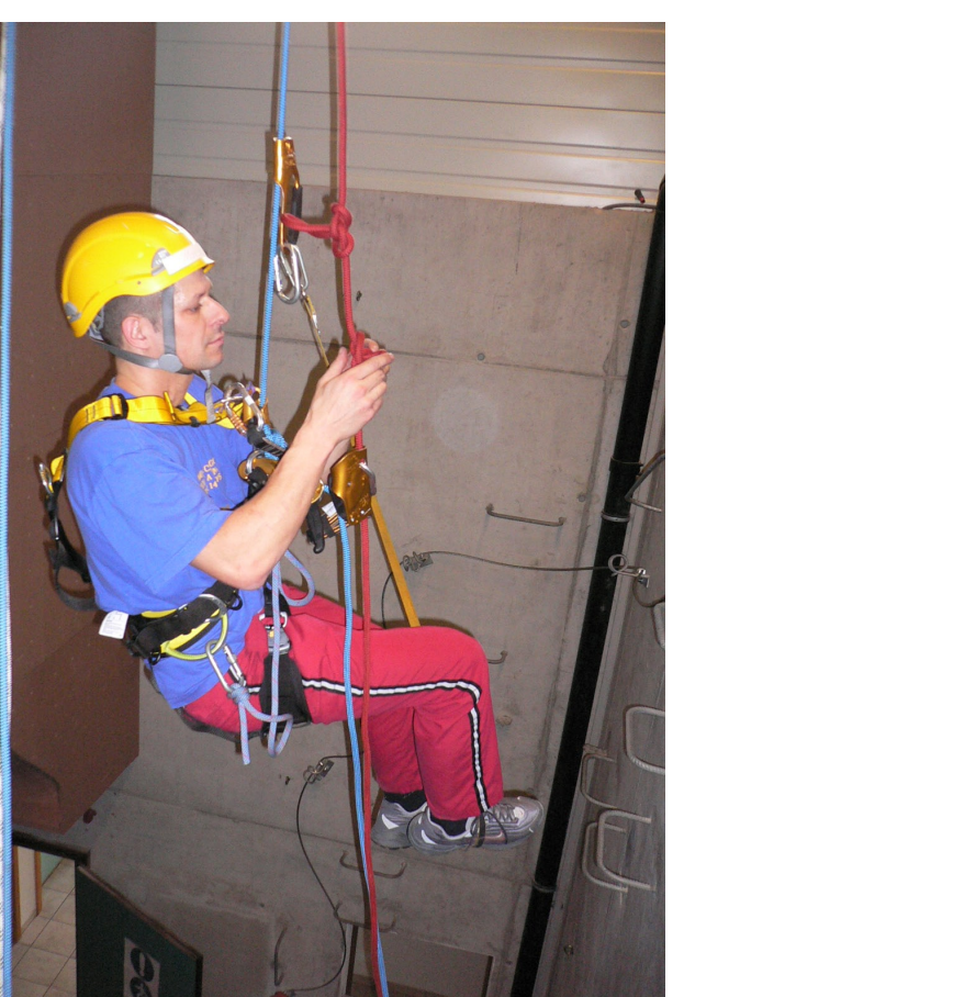
Sicherung von Personen während der Gerüstarbeiten am Turmktogon.
