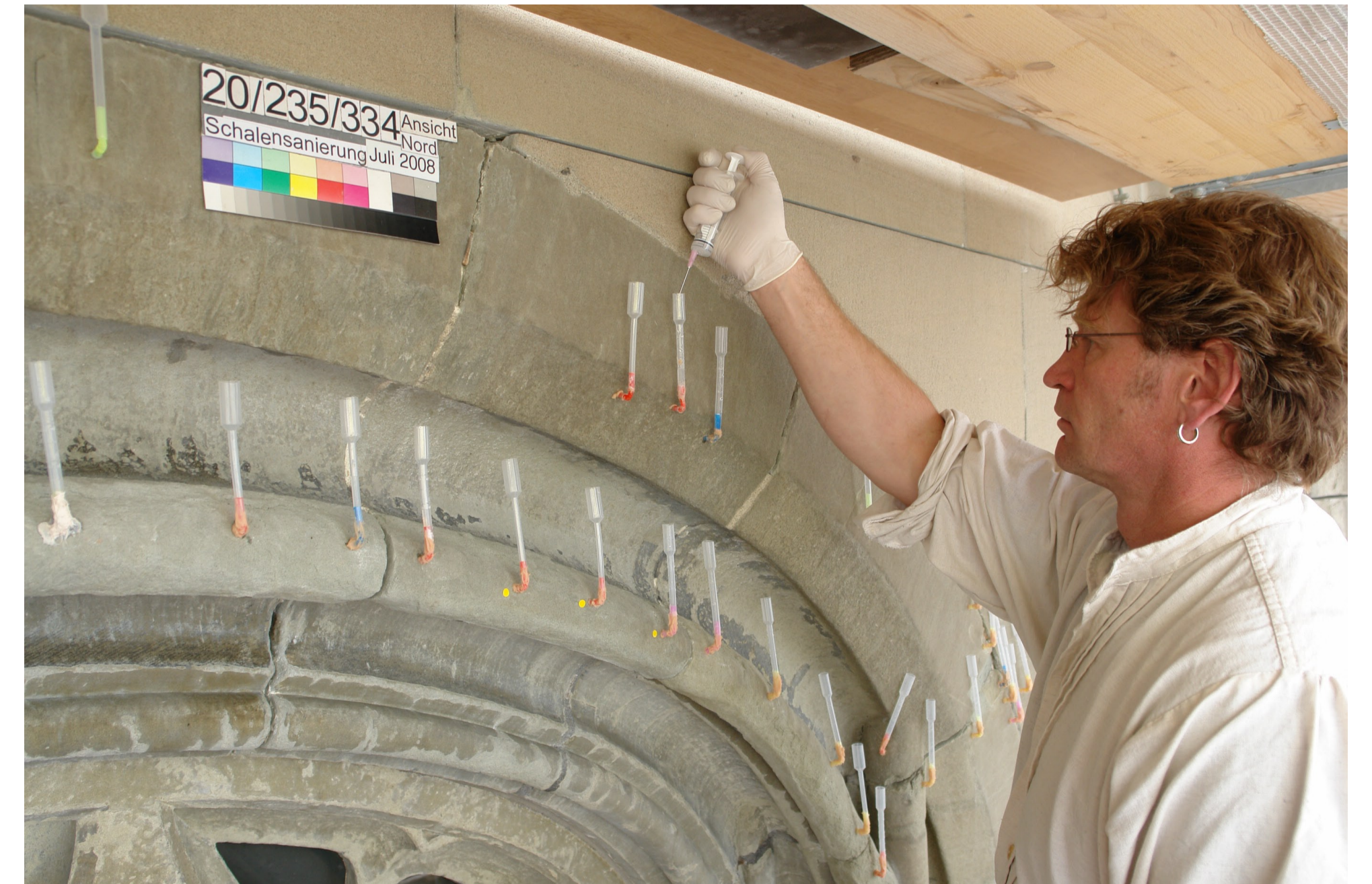
Sichern von Schalen am Fenstermasswerk des unteren Turmachtecks Nord 2008.
