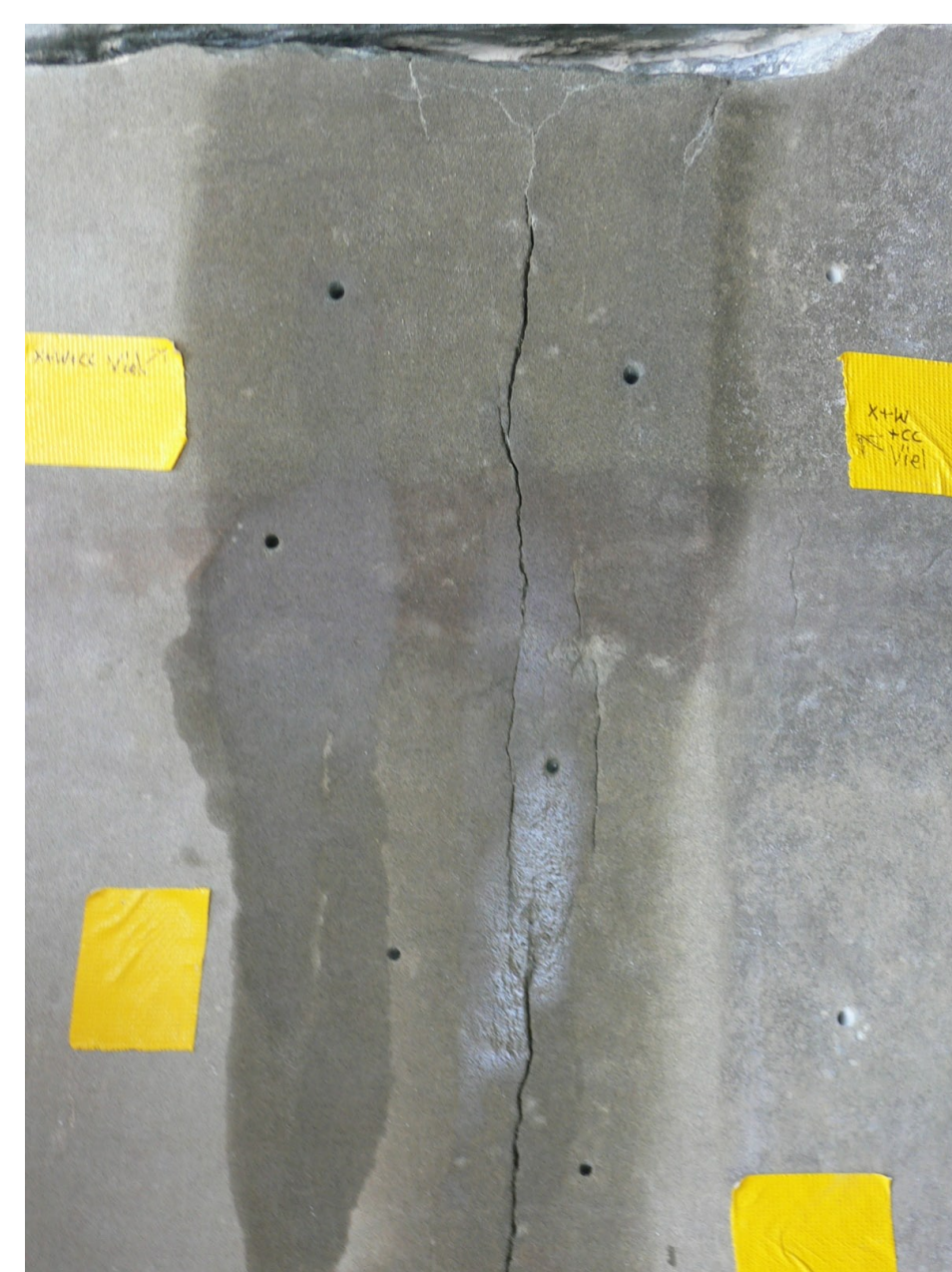
Die Bohrlocher werden gut mit Wasser gespült, damit der Bohrstaub spätere Injektionen nicht behindert. Ausserdem lässt die Aufnahmemenge des Wassers Rückschlüsse auf die später benötigten Injektionsmaterialien und -mengen zu.
