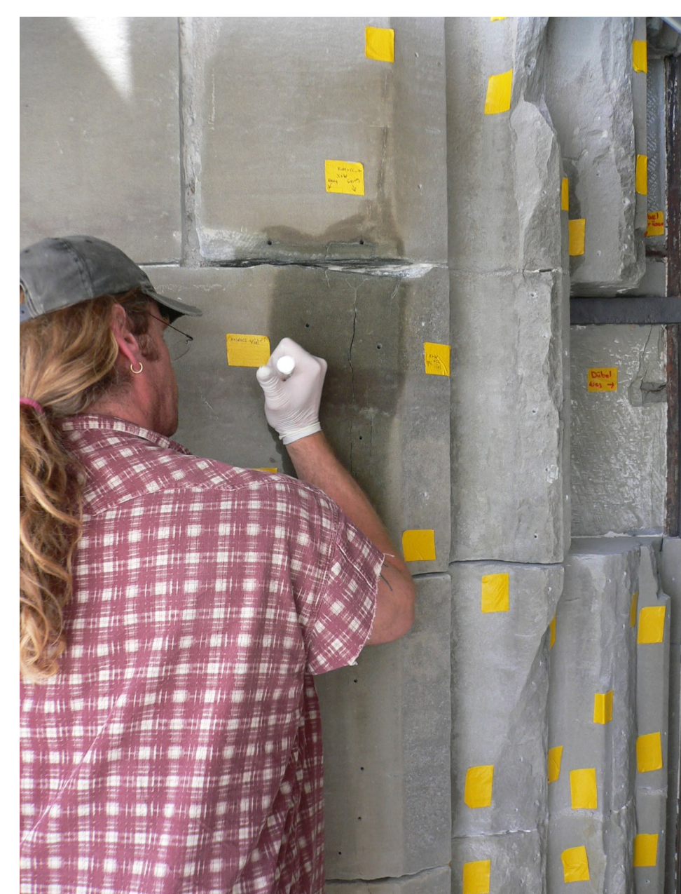
Sichern einer grossflächigen Schale am unteren Achteck.
