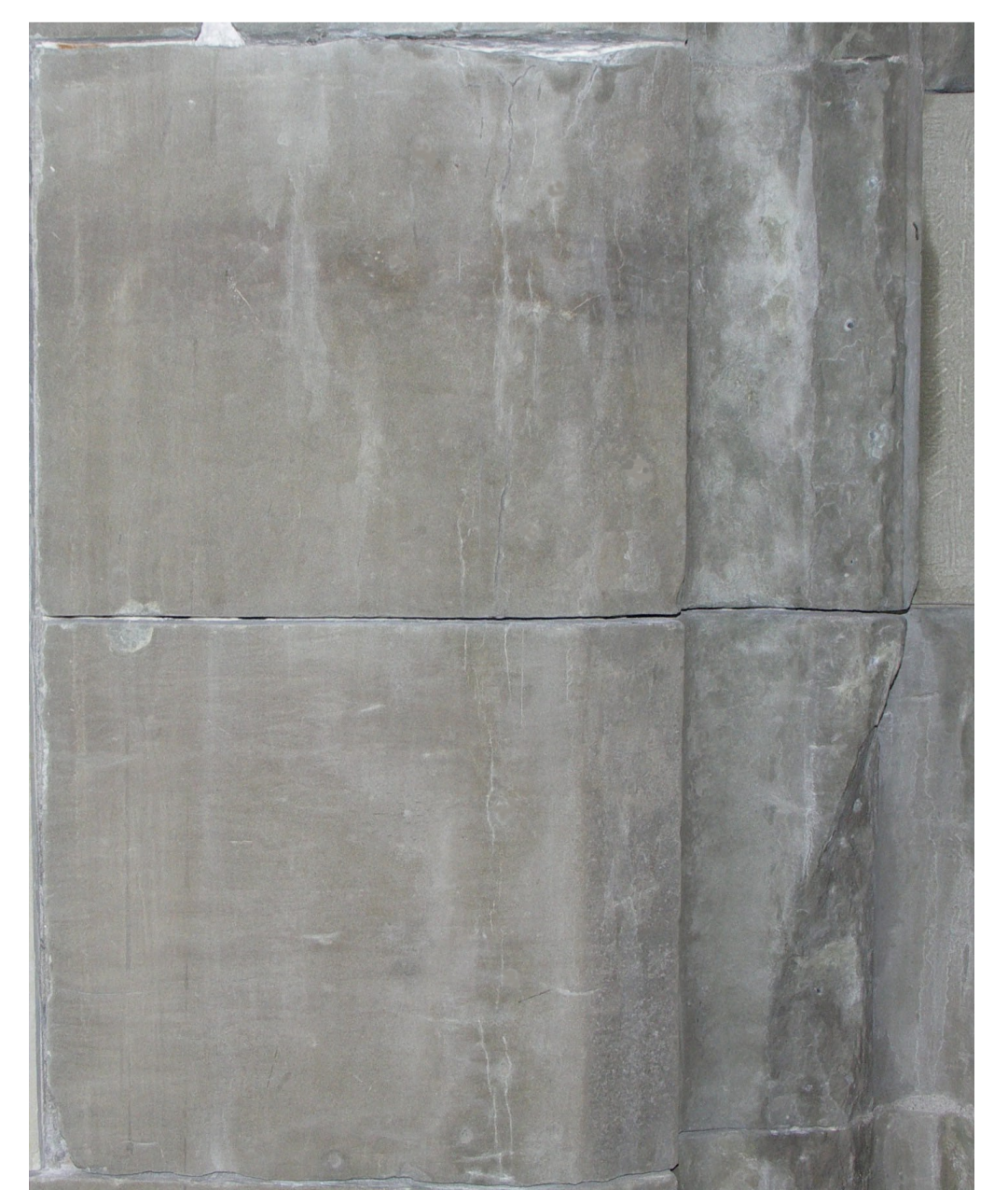
Fertig gesicherte Schale, bereit für Mörtelergänzungen und anschliessendes Verfugen.
