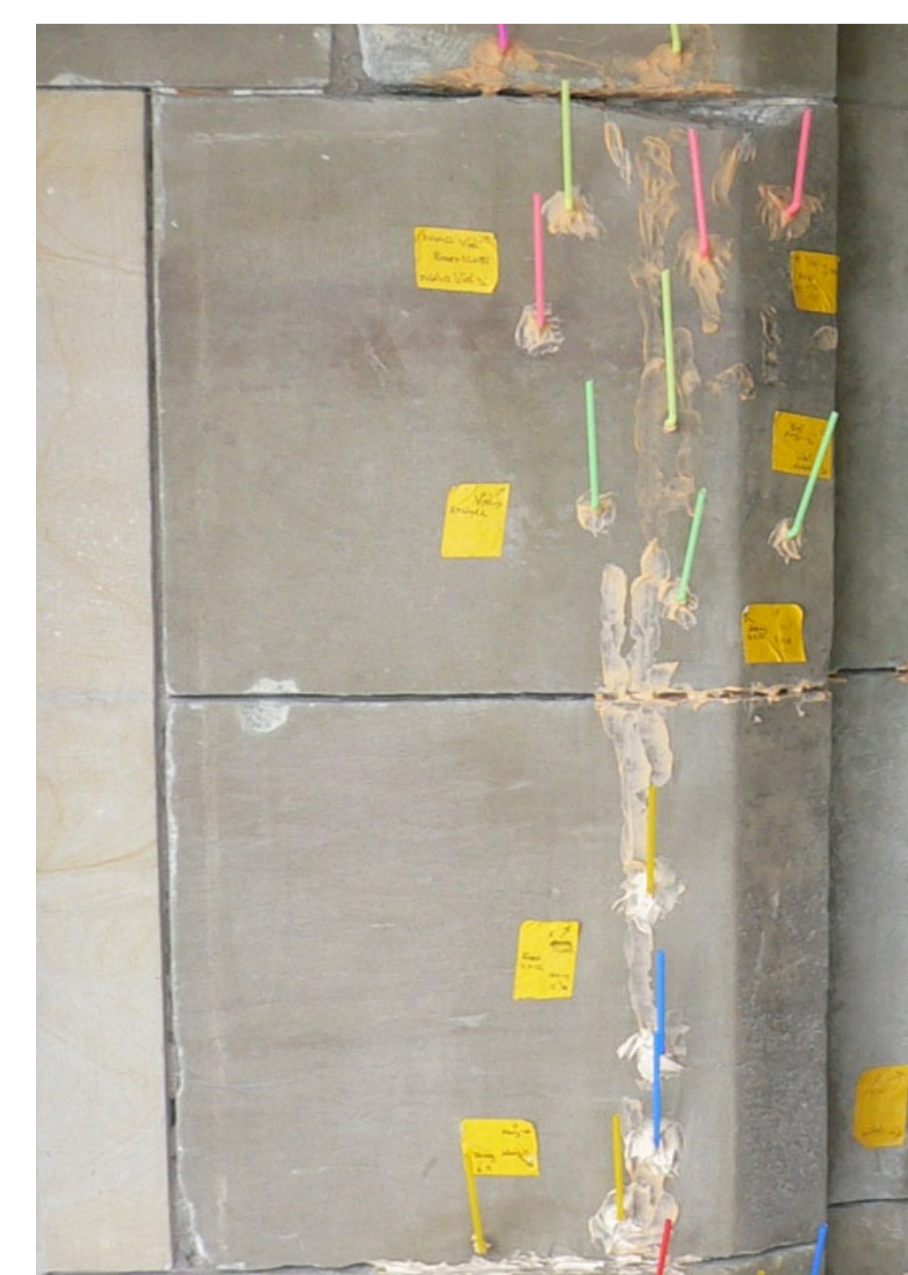
Nach dem Schliessen der Risse wird über aufgeklebte Trinkhalme oder Tropfpipetten das Injektionsmaterial eingefüllt. Abschliessend werden die Bohrlocher mit einer Armierung versehen.
