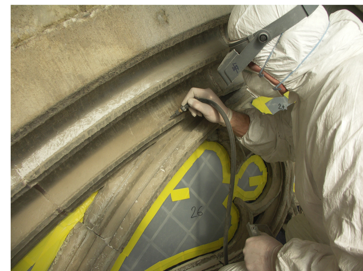
Reinigung mit dem Mikrosandstrahlgerät, das mit einem Luftdruck von 1-2 Bar und der Verwendung von Calciumcarbonat als Strahlgut Verschmutzungen sehr schonend entfernt. Diese Art der Reinigung erfordert grosse Konzentration und viel Übung der ausführenden Person. Gestrahlt wird im Bedarfsfall unter Einsatz einer Stirnlampe.
