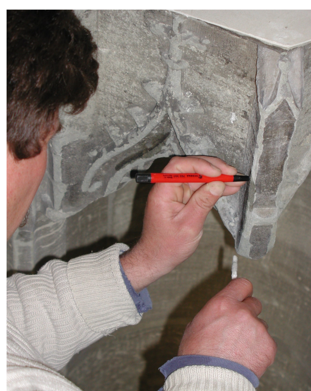
links: Bei ganz heiklen Bereichen, wie hier an einem wertvollen Baldachin aus dem 15. Jh, am östlichen Nordportal, wird vorsichtig von Hand mit Glasfaserstift oder Wattestäbchen und destilliertem Wasser gereinigt.
