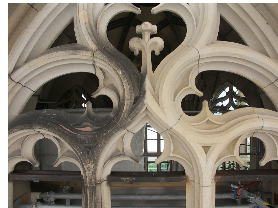
Links: Zustand eines Masswerks am Turmachteck vor und nach der Reinigung mit dem Sandstrahlgerät. Unten: Versuche mit unterschiedlichem Strahlgut auf Oberkirchener Sandstein.
