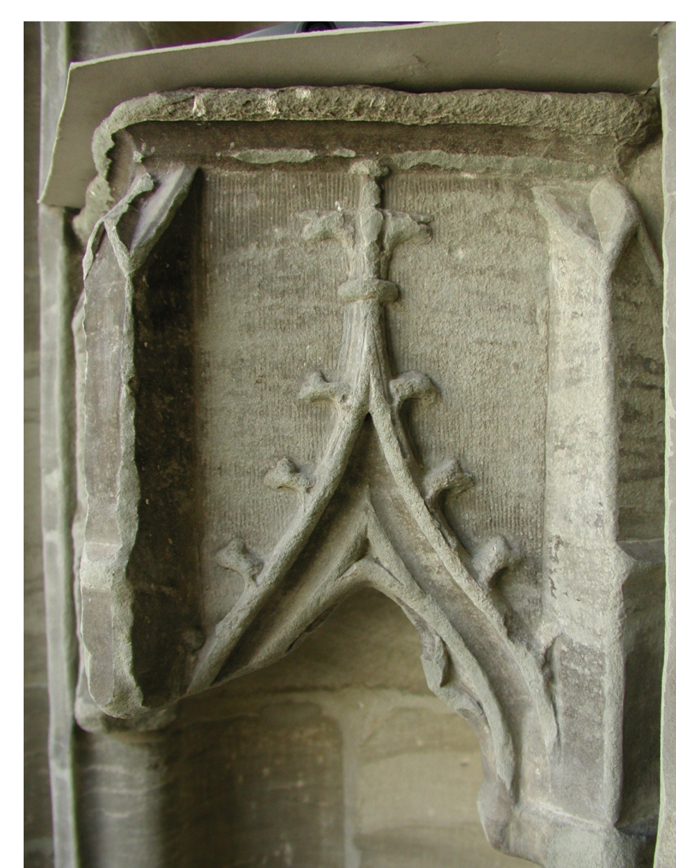
Beispiel problematischer Moospolster, hier an einem Chorpfeiler. Hartnäckiger biogener Bewuchs wird mit Wasserstoffperoxyd entfernt.
