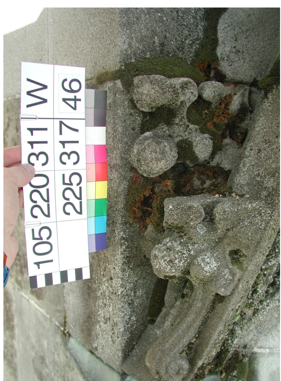
Beispiel problematischer Moospolster, hier an einem Chorpfeiler. Hartnäckiger biogener Bewuchs wird mit Wasserstoffperoxyd entfernt.
