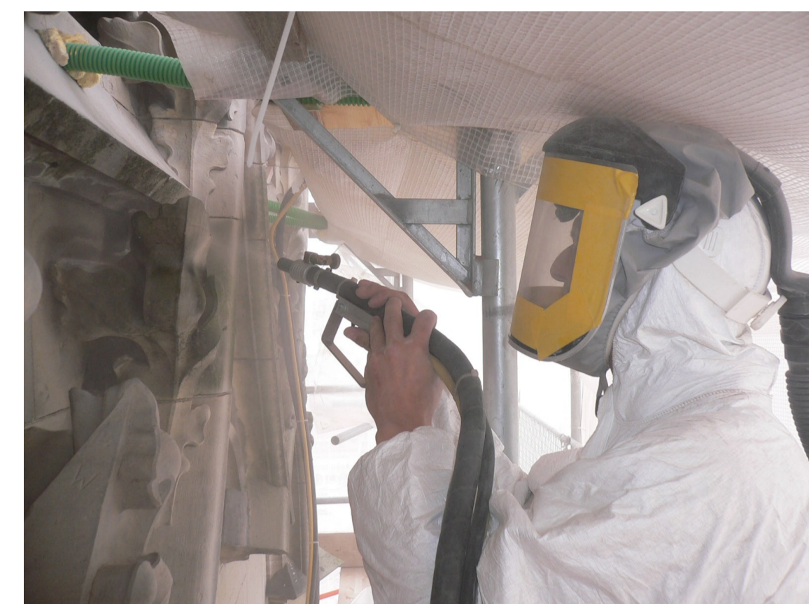
Sandstrahlen von Oberkirchener Sandstein mit Granatsand, oberes Turmachteck Ost
