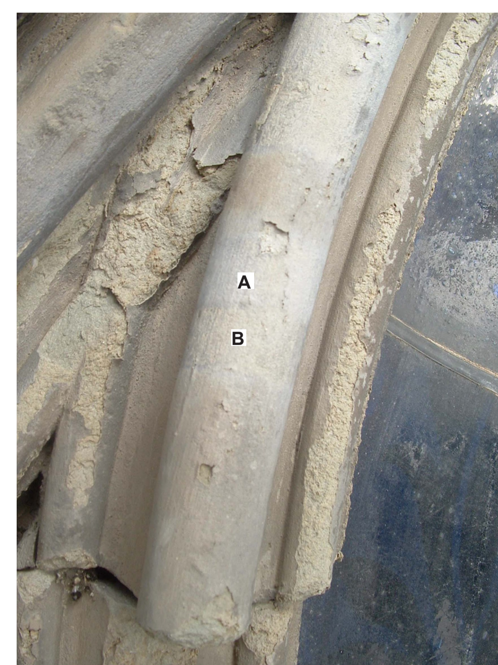
Links: Reinigungsmuster am Fenstermasswerk der Erlach-Ligerz Kapelle. Am Masswerk konnten mehrere noch vorhandene Farbfassungen nachgewiesen werden. Bei der Laborproben von unterschiedlich gereinigten Bereichen zeigte sich, dass auf ein schwach abrasives Strahlgut zurückgegriffen und sehr vorsichtig gearbeitet werden musste. In Bereich B war im Vergleich zu Bereich A bereits eine der unter dem Staub liegenden Farbschichten angegriffen worden.
