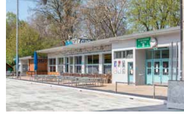
© Kantonale Denkmalpflege Basel-Stadt
