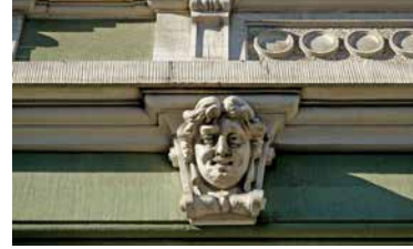
© Kantonale Denkmalpflege Basel-Stadt
