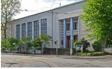
© Kantonale Denkmalpflege Basel-Stadt
