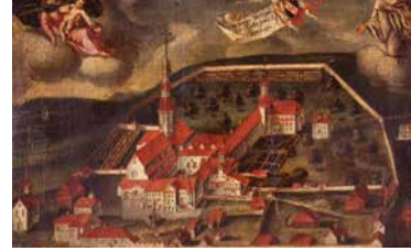
© Denkmalpflege und Archäologie Luzern
