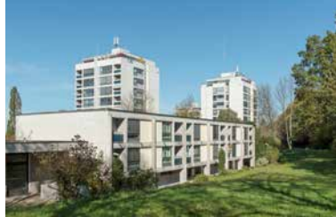
© Kantonale Denkmalpflege Basel-Stadt
