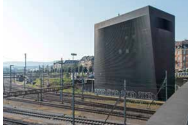
© kantonale Denkmalpflege Basel-Stadt
