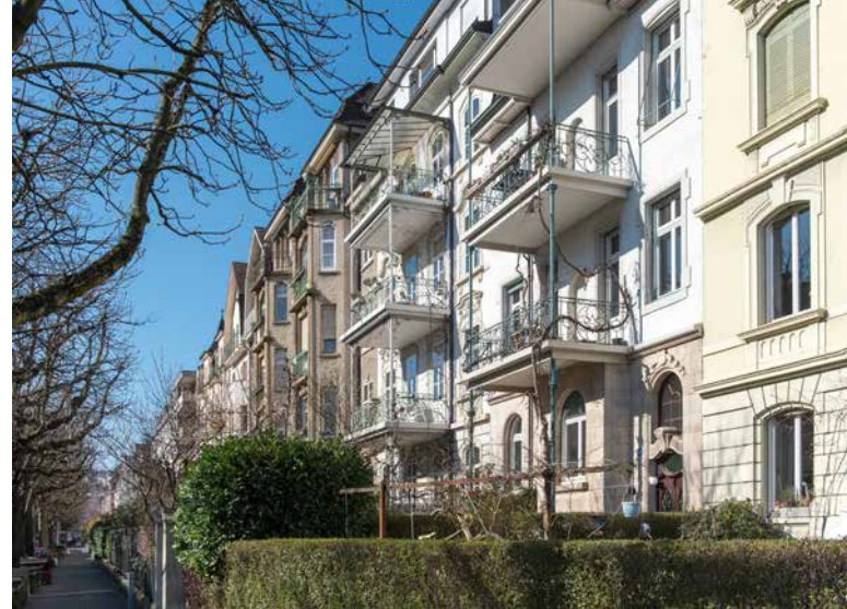
© Kantonale Denkmalpflege Basel-Stadt
