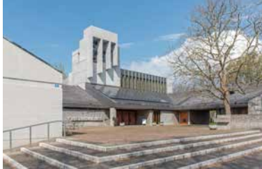
© Kantonale Denkmalpflege Basel-Stadt
