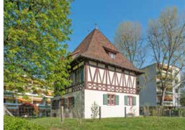
© Kantonale Denkmalpflege Basel-Stadt
