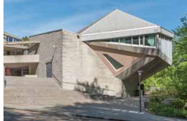
© Kantonale Denkmalpflege Basel-Stadt
