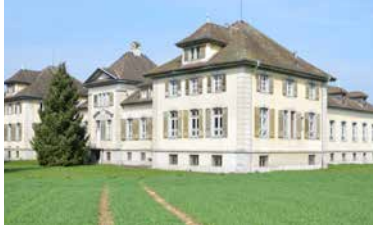
© Denkmalpflege und Archäologie Luzern
