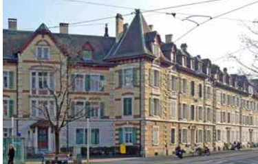
© Kantonale Denkmalpflege Basel-Stadt
