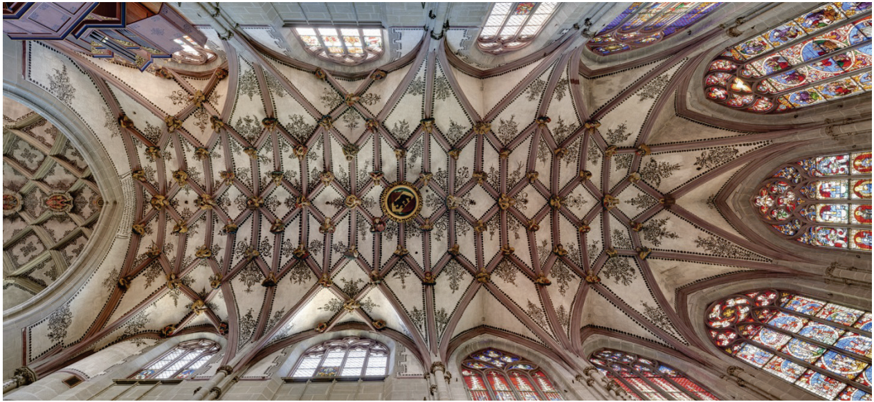
Restauriertes Chorgewölbe | Foto Nick Brändli, 2018
