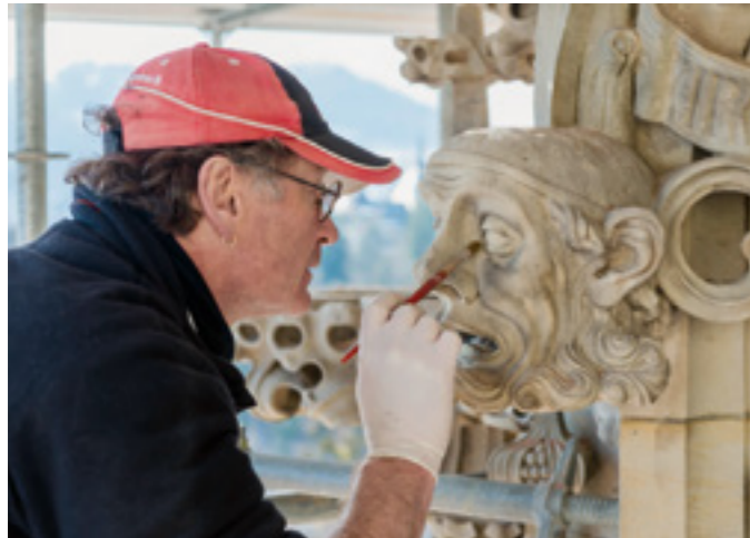
Mit dem Pinsel entfernt Marcel Maurer Schmutz von einem gotischen Element an der Aussenwand.
