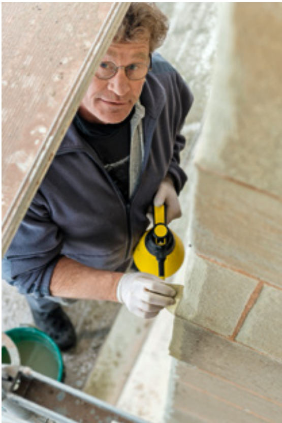
Mit Schwämmchen und Wasser reinigt Marcel Maurer das Mauerwerk.
