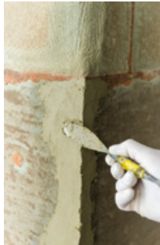
Die roten Stellen stammen vom Mörtel, der im 18. Jahrhundert zur Restaurierung verwendet wurde.
