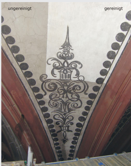
Gewölbekappe mit Reinigungsmuster
