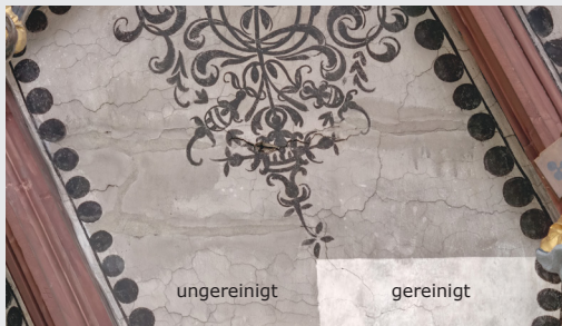
Vor der Reinigung: vermörtelte Risse wurden der gräulich-verschmutzten Gewölbekappenfarbe angepasst
