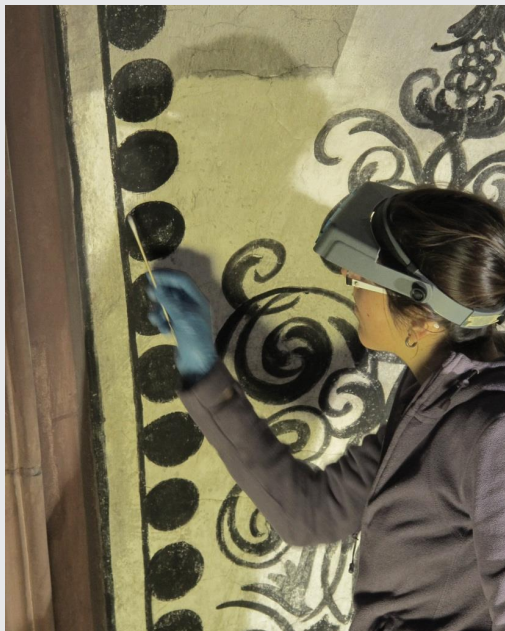
Feuchtreinigung in heiklen Bereichen, wie zum Beispiel bei den unzähligen bauzeitlichen Schwundrissen
