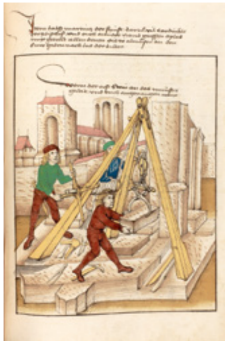
Gewichtheber: Mit Haspel und Flaschenzug konnten die Arbeiter schwere Lasten heben. Das Bild stammt aus der Spiezer Chronik von Diebold Schilling (1485).
