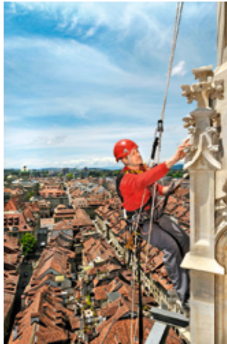
Ein Job für Schwindelfreie: Steinmetz Marcel Schwegler bei der Arbeit am Münsterturm.
