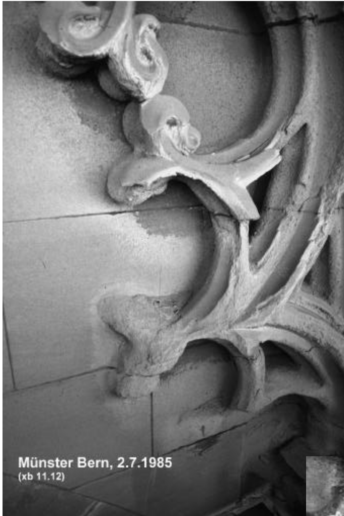
Figur 8: Detail aus Figur 7. Schalenbildung entlang des Masswerks mit relativ intakter Oberseite über einer Lockerzone. Unterseite der Stäbe und Krabben stark aufgelockert und sandend. Im Regenschatten schwarze Gipskruste am unmittelbaren Übergang zum berechneten Bereich starkes und darunter schwaches Absanden.
