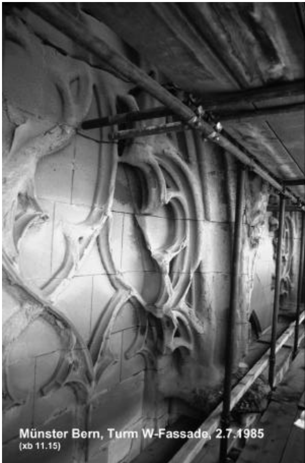
Figur 6 : Nördlicher Teil der Turm-Westfassade unterhalb von Figur 9
