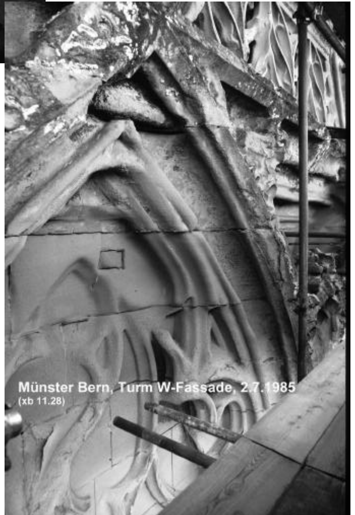
Figur 9: Stark absandende Bereiche direkt unterhalb der Galerie, oberhalb Figur 6
