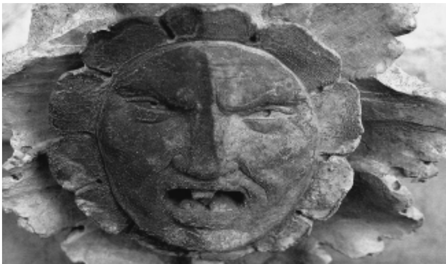
Sonne über dem Kapitell beim Hauptportal. Rechte Gesichtshälfte mit Laser gereinigt. Foto: Andreas Küng.
