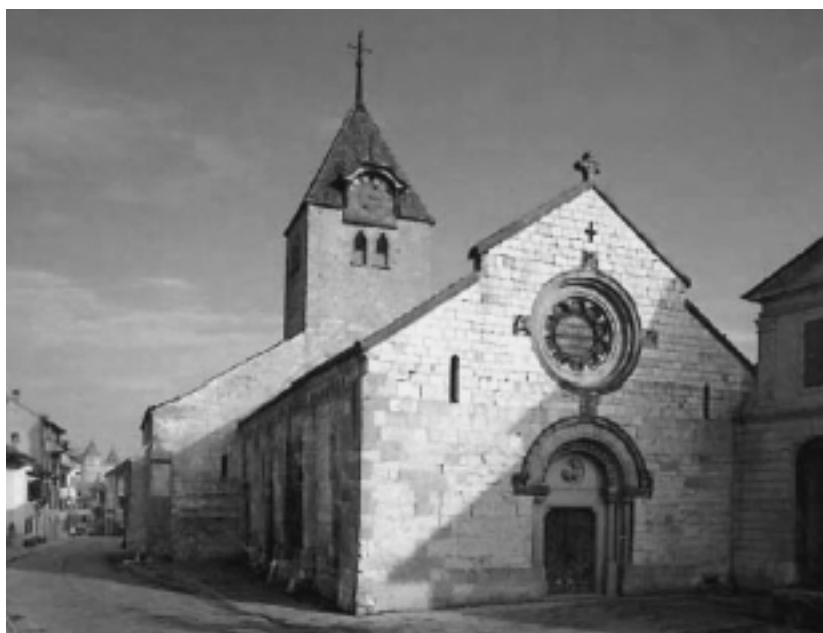
Façade ouest de l'église St-Jean à Grandson avec un parement en calcaire et molasse. Photo: F. Girardet
